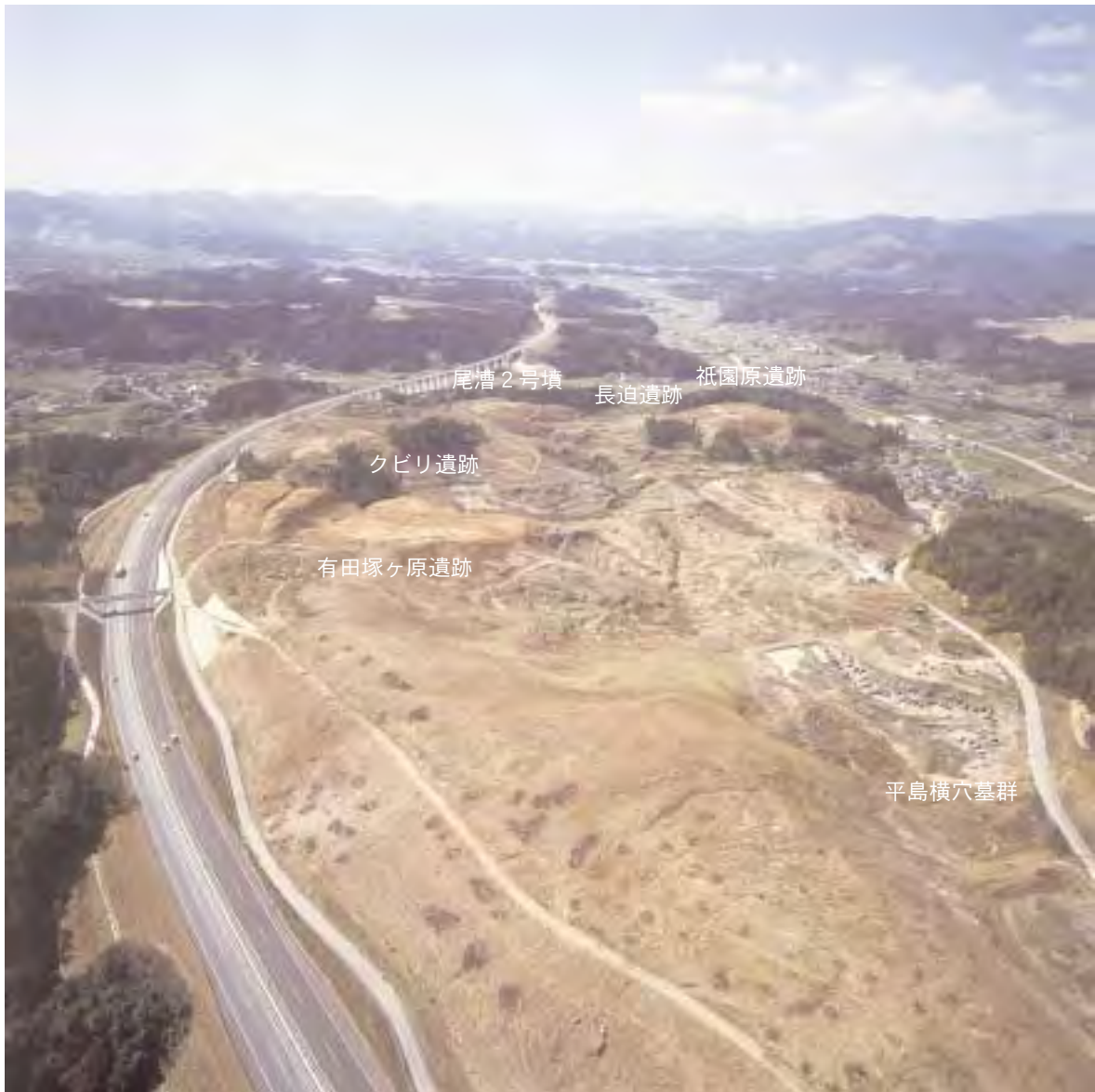
ウッドコンビナート計画地遠景（東から）
