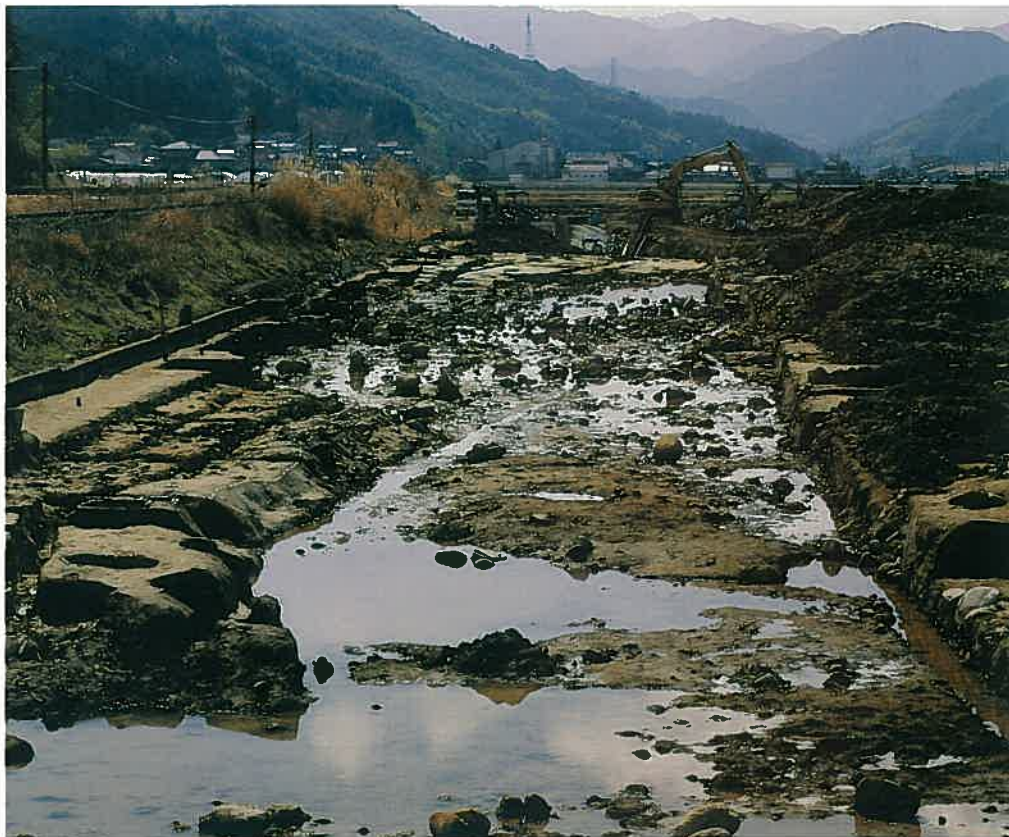
調査区近景（北から）
