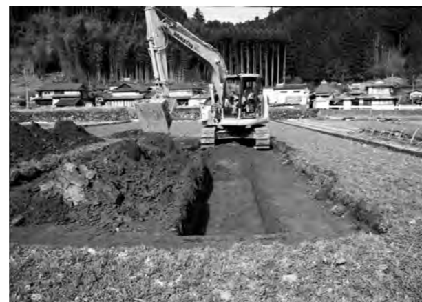
写真2 試掘調査風景
