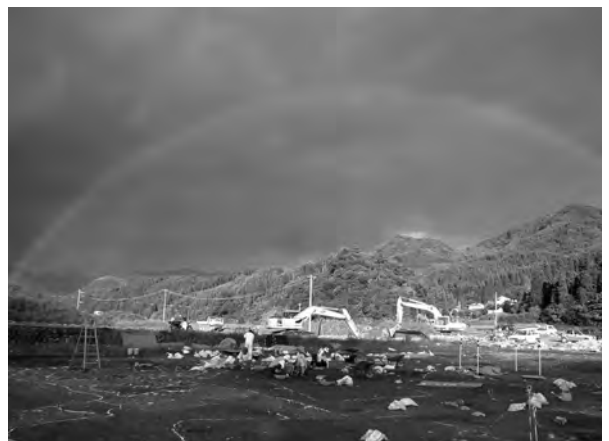
写真5 B-1区作業風景
