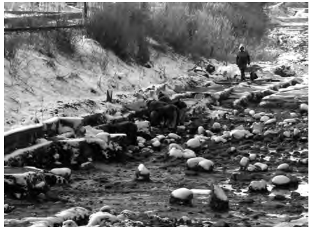
写真3 A-2区作業風景
