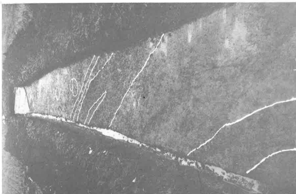
2. T-2 全景 (南から)
