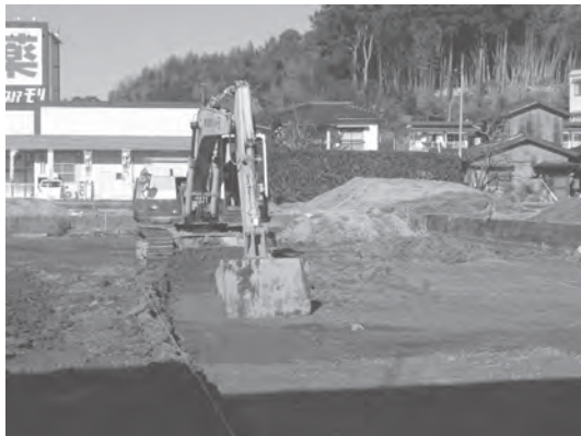
写真2 重機作業風景
