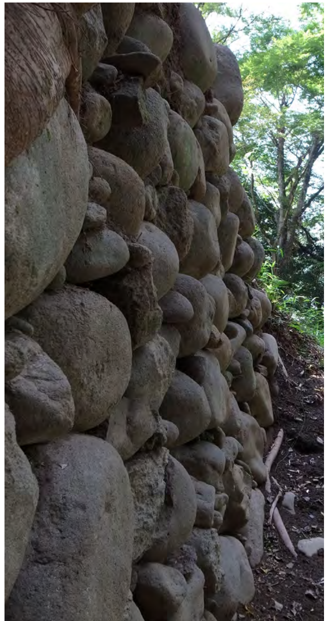
3. 天守跡西石垣 (番号 2) 検出状況 (北から)
