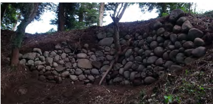
4. 本丸跡北石垣 (番号 3) 検出状況 (北から)
