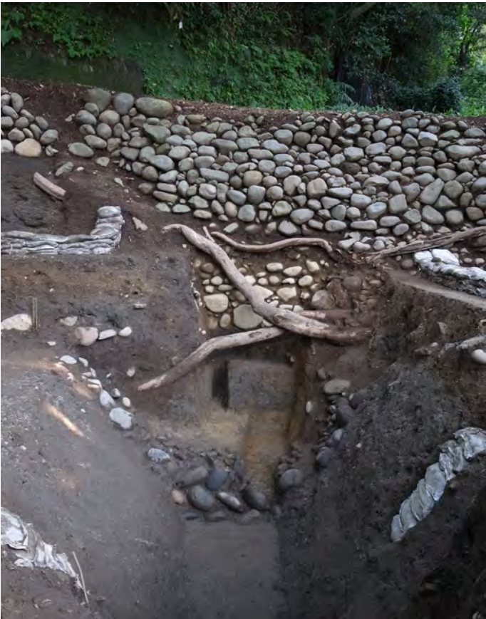
3. 堀・曲輪⑧北石垣 (発掘 3 次 3 トレンチ) 発掘状況① (北から)
