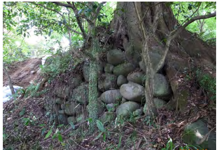
3. 天守跡石垣(番号1)検出状況
