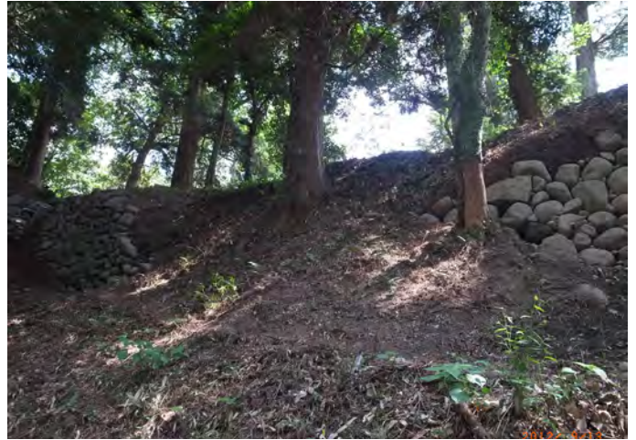
2. 本丸跡北石垣 (番号 3) 検出状況② (北から)
