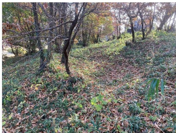
第12図 鞠智城内5号(米原1号)近景(西より)
