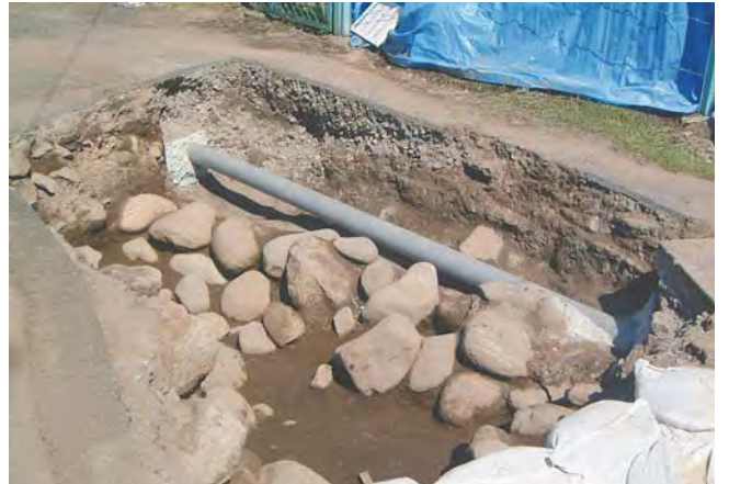
② 1号墳第2・3・7トレンチ列石検出状況（南東から）
