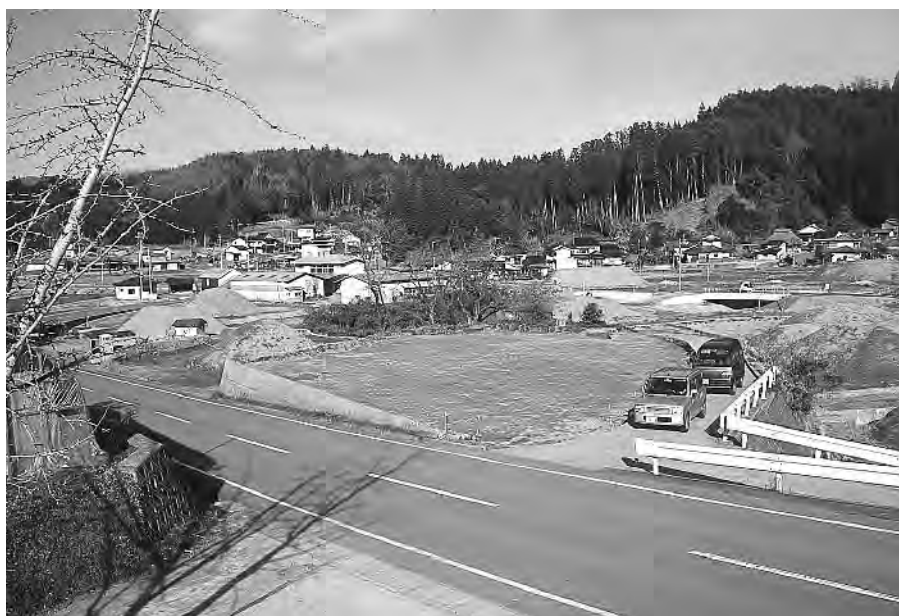
B地点全景（西から）
