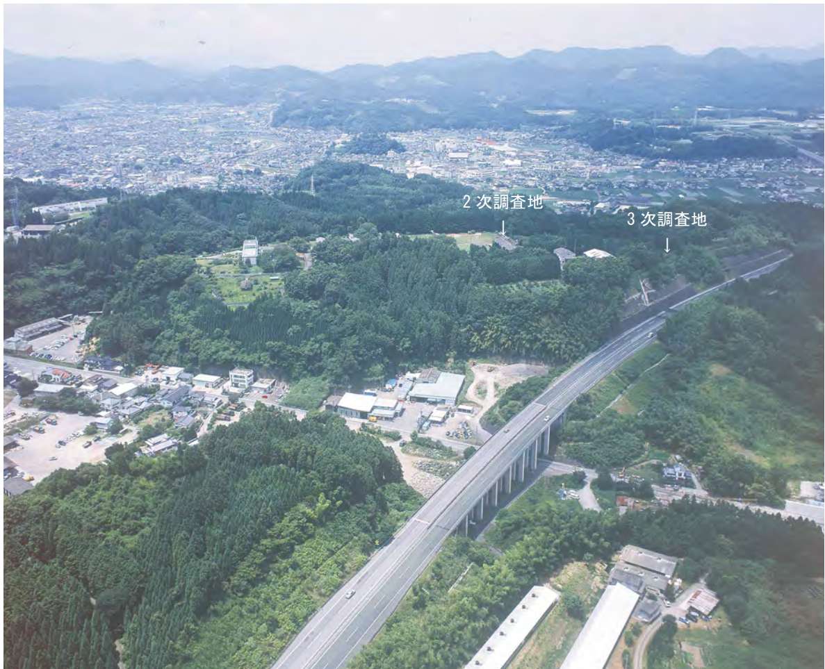
佐寺原遺跡全景（北から）
