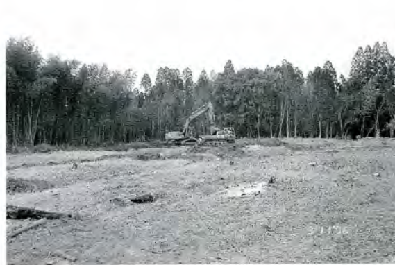
写真2 表土除去風景
