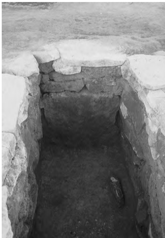
4号墓小口壁石積状況
