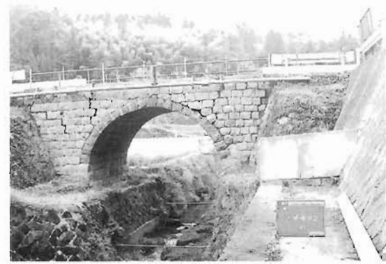
清掃後（下流側）
