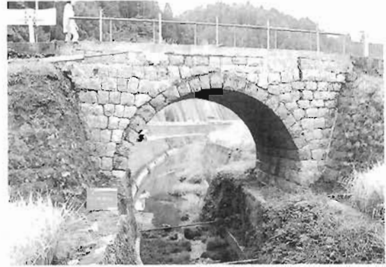
清掃後（上流側）
