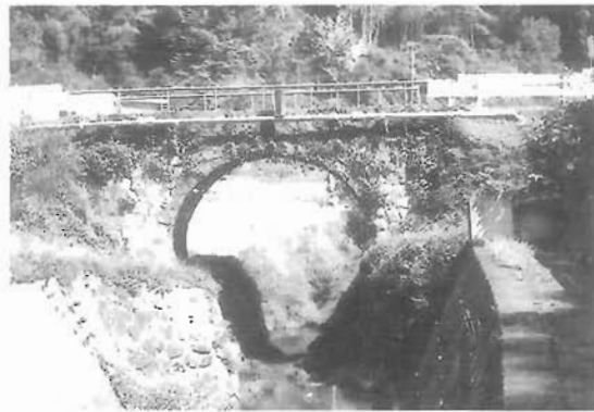
着工前（下流側）
