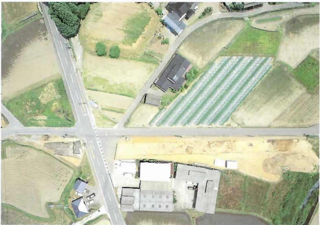
D-1区全景（真上から）
