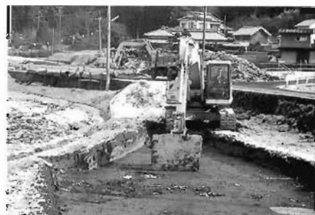
写真2 重機作業風景
