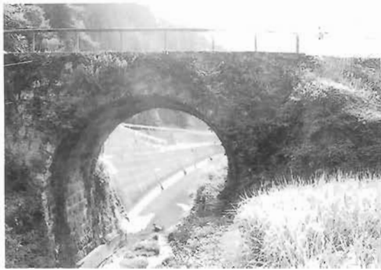
着工前（上流側）
