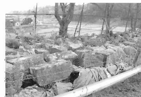
解体後の石材保管状況
