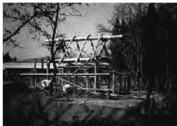
工事中の復元住居②
