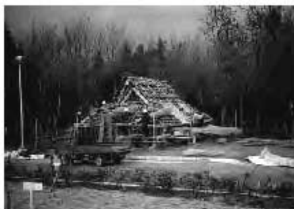
工事中の復元住居⑤
