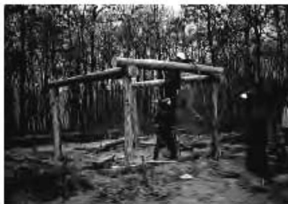
工事中の復元住居①
