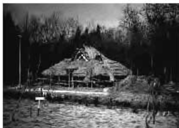
工事中の復元住居⑥
