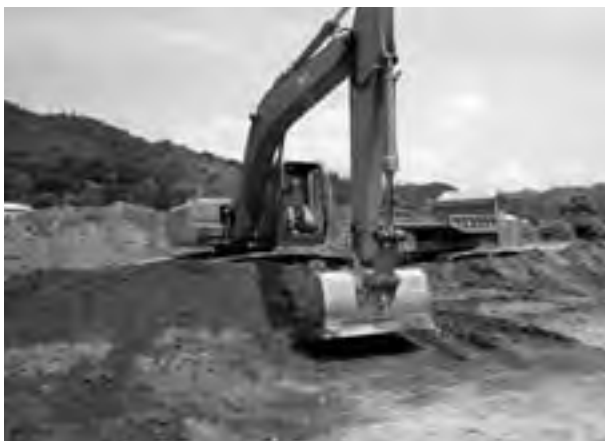
写真 6 機械作業風景
