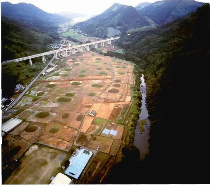
遺跡周辺空中写真（南から）
