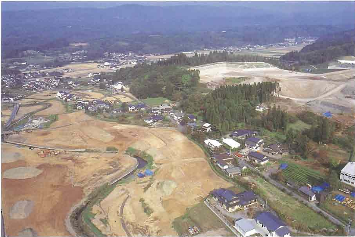
尾漕遺跡 4次調査区全景（南方向より）
