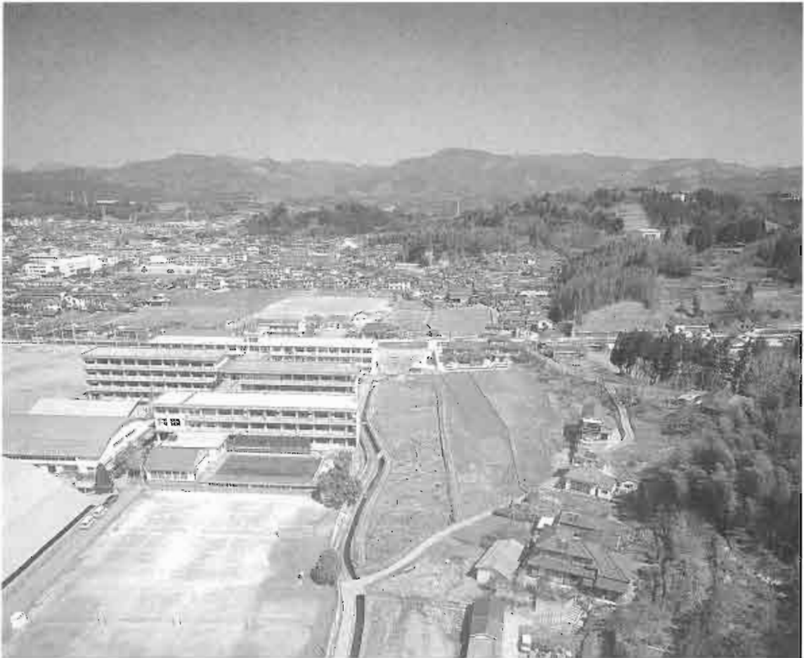
①B区全景（南から）
