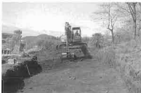
写真1 機械作業風景
