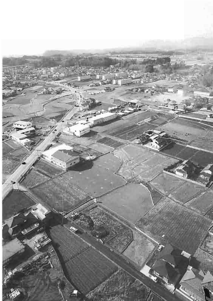
1.調査区全景写真(北から)
