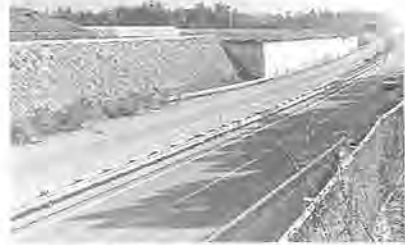
小迫辻原遺跡の保存擁壁
