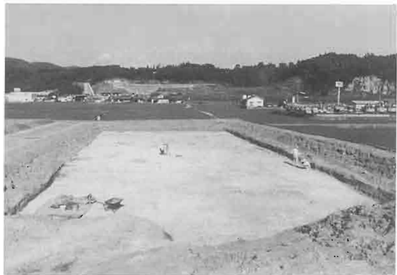
2区の作業風景
