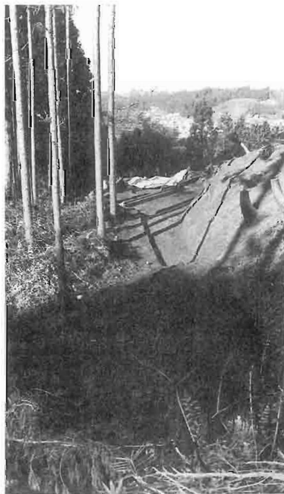
B区全景(南より)
