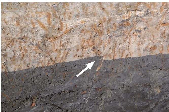
10号墳で確認された地割れの跡
