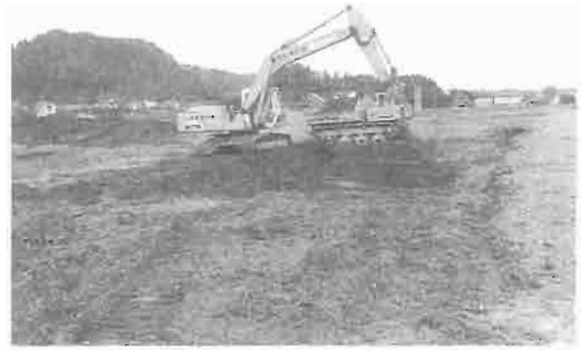
機械による表土剥ぎ作業風景
