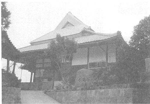
写真41 教恩寺本堂側面
