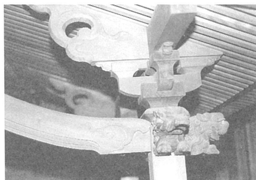
写真10 同 向拝組物・海老虹梁・手挟
