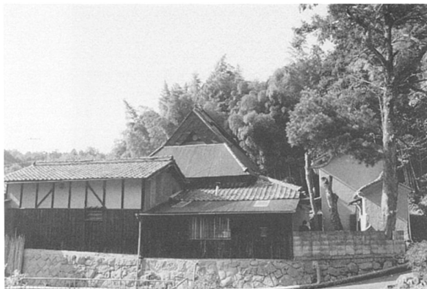
屋敷構え遠景 (その2)
