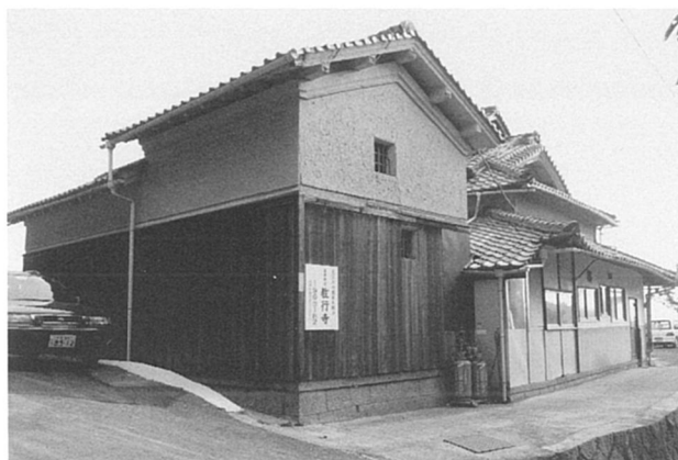
主屋背後の土蔵外観
