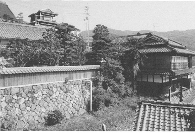
屋敷構え遠景(その2)
