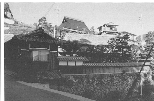
屋敷構え遠景 (その1)
