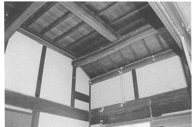
土間上部の梁組
