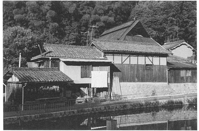
屋敷構え遠景 (その1)
