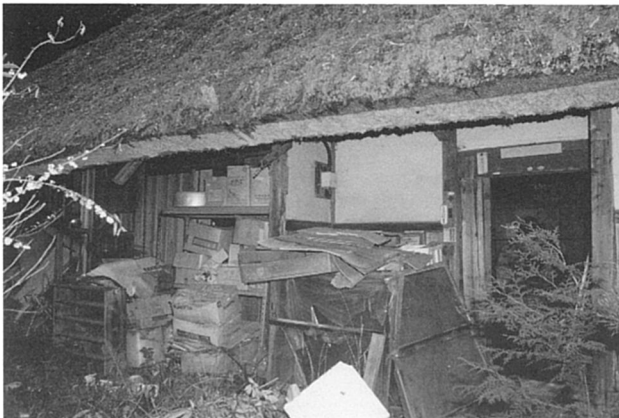
外観・出入口まわり
