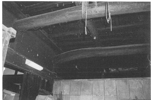
土間上部の梁組
