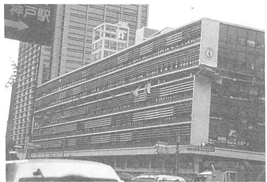
写真1 兵庫県南部地震で大被害を受けた神戸市役所
