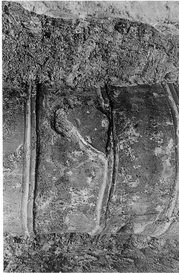
1. 井戸H-10 3段目井筒埴輪透孔閉塞状況(西から)
