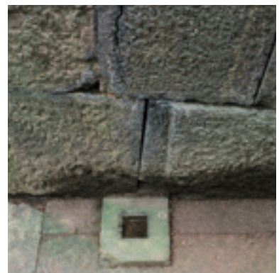
石段踊り場北西の柄穴（南から）
