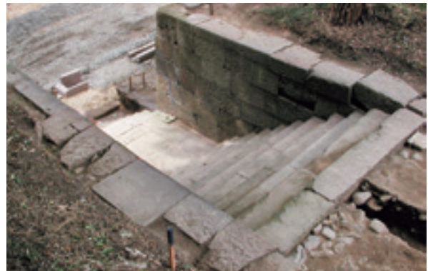
全景（南東から）
