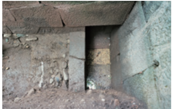
石組溝1 B 検出状況 (南西から)
