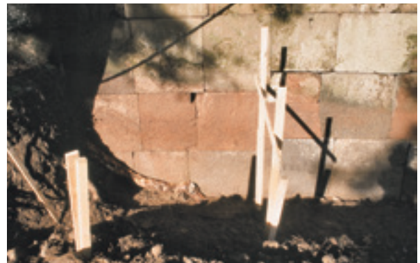
裏口門西石垣東面南側 下部検出状況
