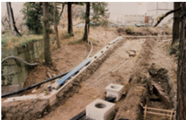
裏口門周辺（西から）
