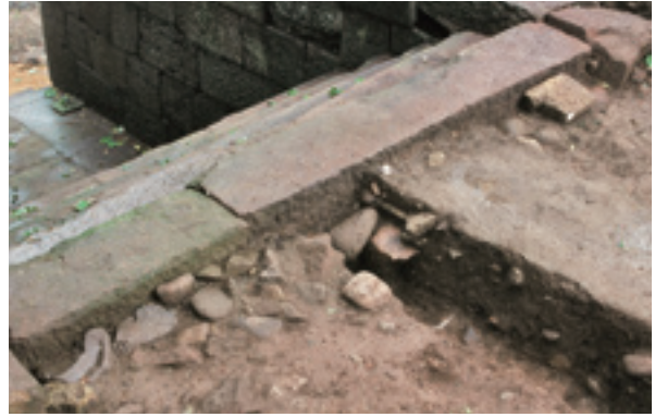
石段1 最上段 背面の根固め石 (南から)
