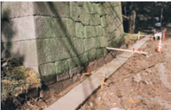
土橋門西石垣東面 (3620E) 下部 全景
