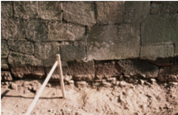
土橋門東石垣西面中央 下部検出状況
