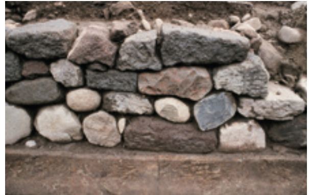
2000-1地点 石組暗渠 1 石垣面
