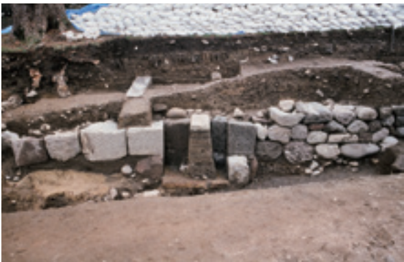
2000-1地点 石組暗渠1石垣面
