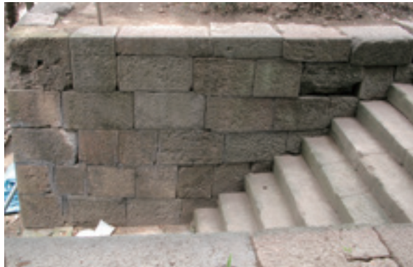
石段1 北側壁石垣
