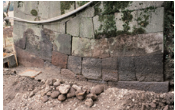
裏口門東石垣西面 下部検出状況
