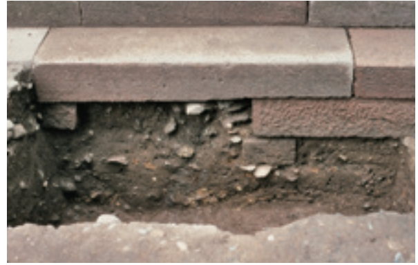
石段1 基礎 土層断面 (北西から)
