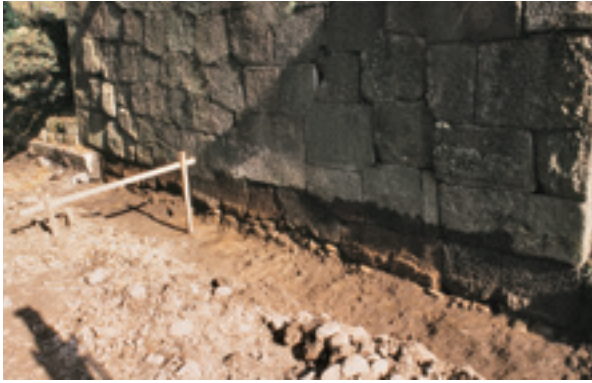
土橋門東石垣西面 (3610W) 下部 全景
