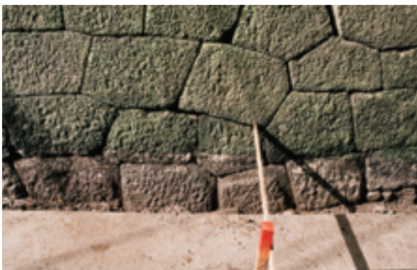
土橋門西石垣東面中央 下部検出状況
