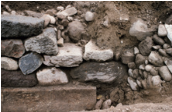
2000-1地点 石組暗渠 1 石垣面
