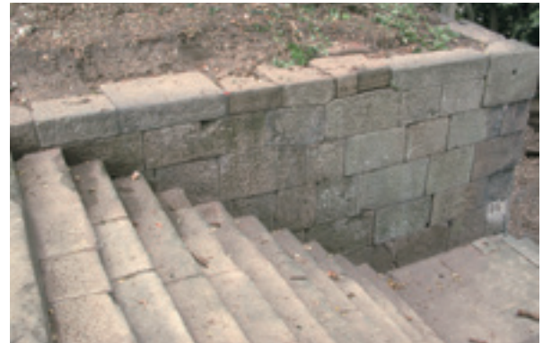
石段1 南側壁石垣
