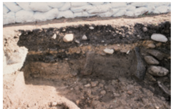
2000-1地点 調査地点東壁土層断面（石組暗渠 1）
