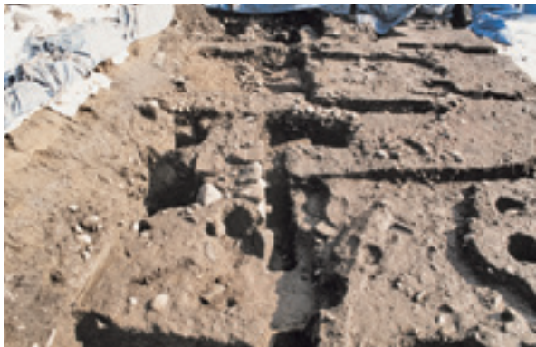
堀基礎 検出状況 (西から)
