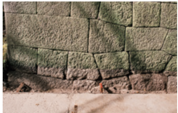
土橋門西石垣東面南側 下部検出状況
