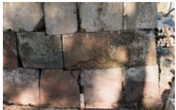
裏口門西石垣東面北側 下部検出状況
