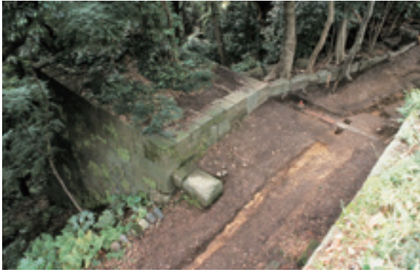
全景（南東から）
