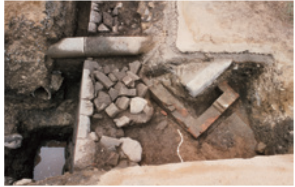
トレンチ3 遺構検出状況（東から）
