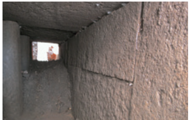
石組溝1 内部 側板検出状況 (北東から)
