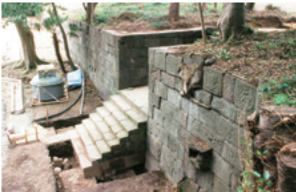
石段1 下段 全景 (南西から)
