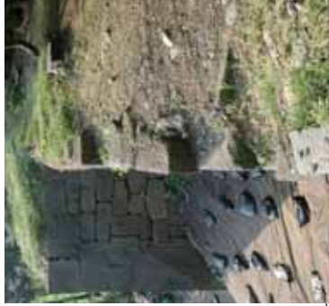
天端石の欠落箇所と流土。菱形箇所の石垣横断の通りはやや湾曲（修景前）
