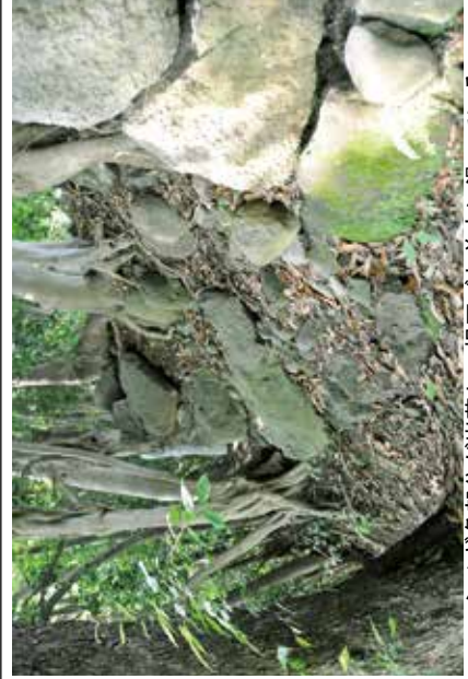
シノギ角部分が崩落し、根石ごと前方に滑っている
