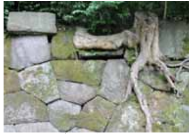
天端石の迫出し 樹木による石面の乱れ
