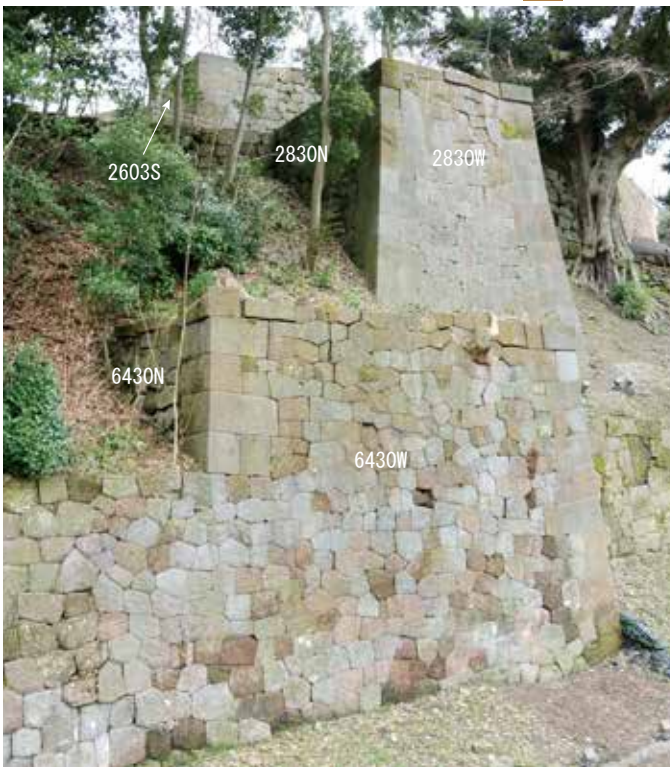
玉泉院丸北御居間先土蔵下石垣 (2603S) 数寄屋門台及び数寄屋門下泉水縁石垣と同じく、縦方向の連続した目地の開き(約4cm) 上下に連続する石垣群の配置状況から、地盤沈下等の関連性が指摘される。
