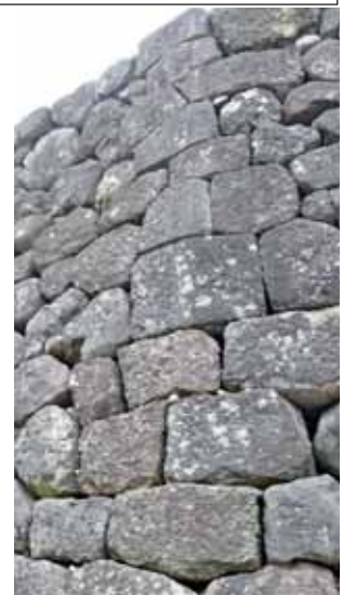
シノギ角の上から6段目で稜線加工が変化
