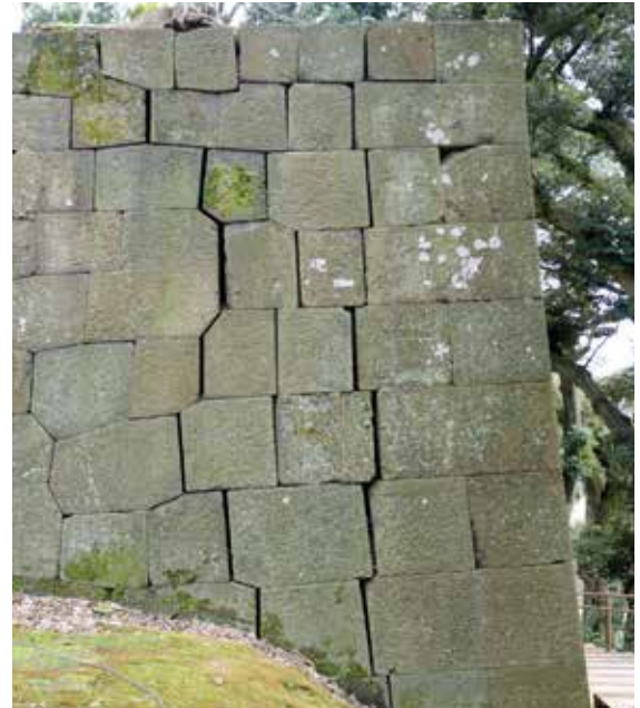
玉泉院丸北御居間先土蔵下石垣 (2603S) 数寄屋門台及び数寄屋門下泉水縁石垣と同じく、縦方向の連続した目地の開き(約4cm) 上下に連続する石垣群の配置状況から、地盤沈下等の関連性が指摘される。
