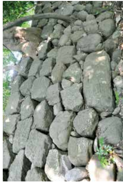
上半部は粗加工石主体 下半部には河川駆石の自然石が多くみられる
