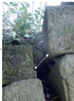
前後の開きだけでなく、上下のずれも確認 (矢印が本来の接点)
