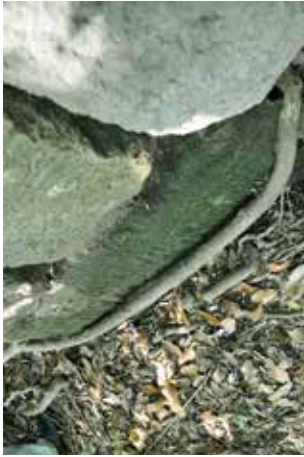
出窓部分には切石材を使用
