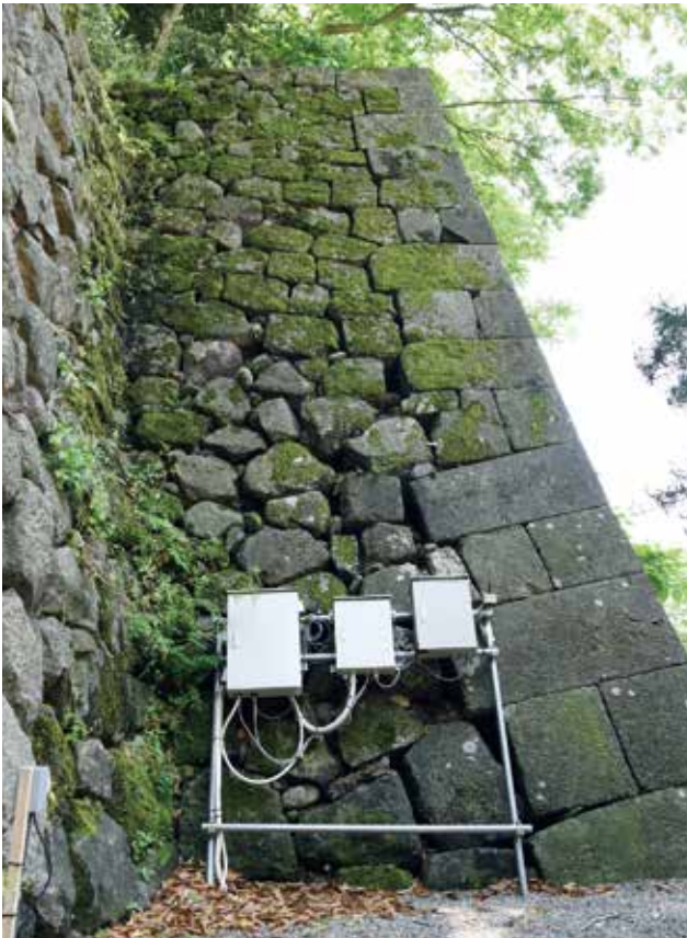
4 6500N 北西隅角部 北から・西から
