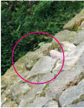
1 石が前に迫出し 周辺の石も引き出されず 局所的に孕み出す
