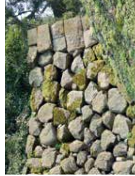
孕み出しが顕著な箇所 上部は後へ転倒する ように窪む
