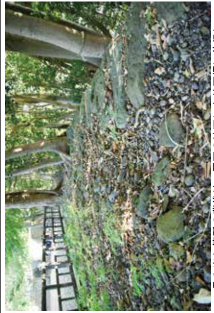
孕み出し箇所の背後は、栗石の沈下により石垣に並行し 浅い溝状に窪む
