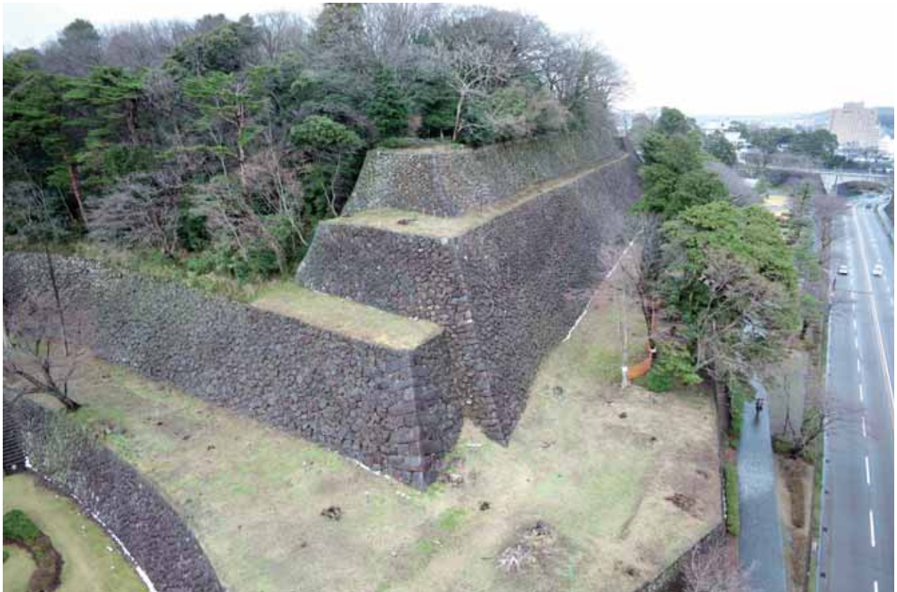
2 1130E、1131E 南東から
