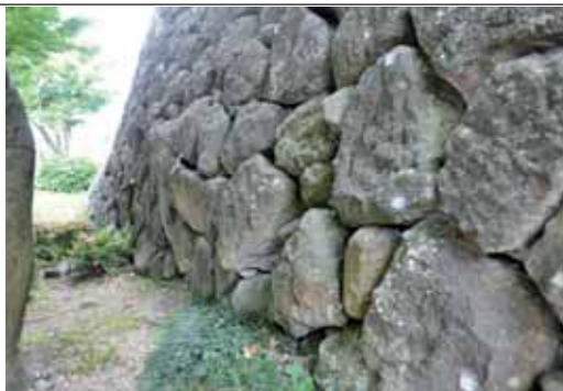
前倒れする変形を残したまま、上部の改修が行われたため、改修境で勾配が異なる
