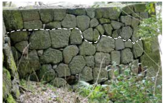
粗加工と切石材の布積み、ノミ痕に粗密があり、上2・3段に細かなものが集中する傾向
