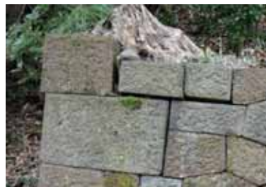
天端角石に転用材
