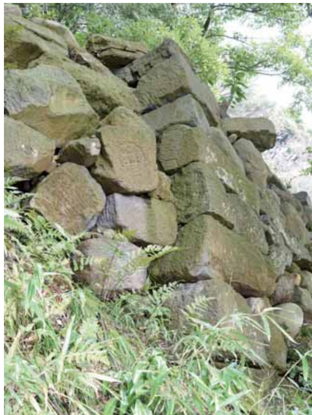
2 1640W、1641S 西から 前方向へ弓なりに変形
