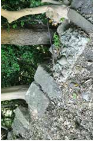
根が目地の隙間に埋めるように成長
