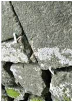
簡易計測 (クラックゲージ)
