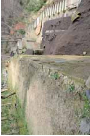
石垣横断の通りは、様相境で修築及び変形に伴い湾曲する
