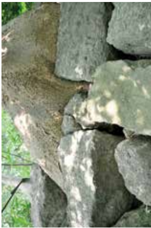
根が目地の隙間に埋めるように成長
