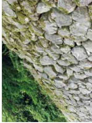
1 石が前に迫出し 周辺の石も引き出されず 局所的に孕み出す
