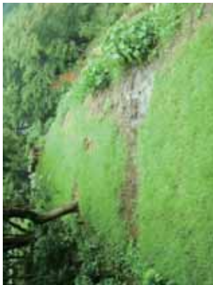
天端周辺は地形的に低いため、降雨時に周辺の雨水が流れ込み、洗掘される状況（修景前）
