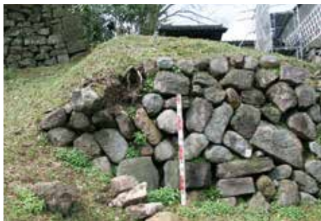
2010年3月に左上部が9石転落 オーバーハングした崩壊崖を整形し、 土嚢詰めとシートで応急養生
