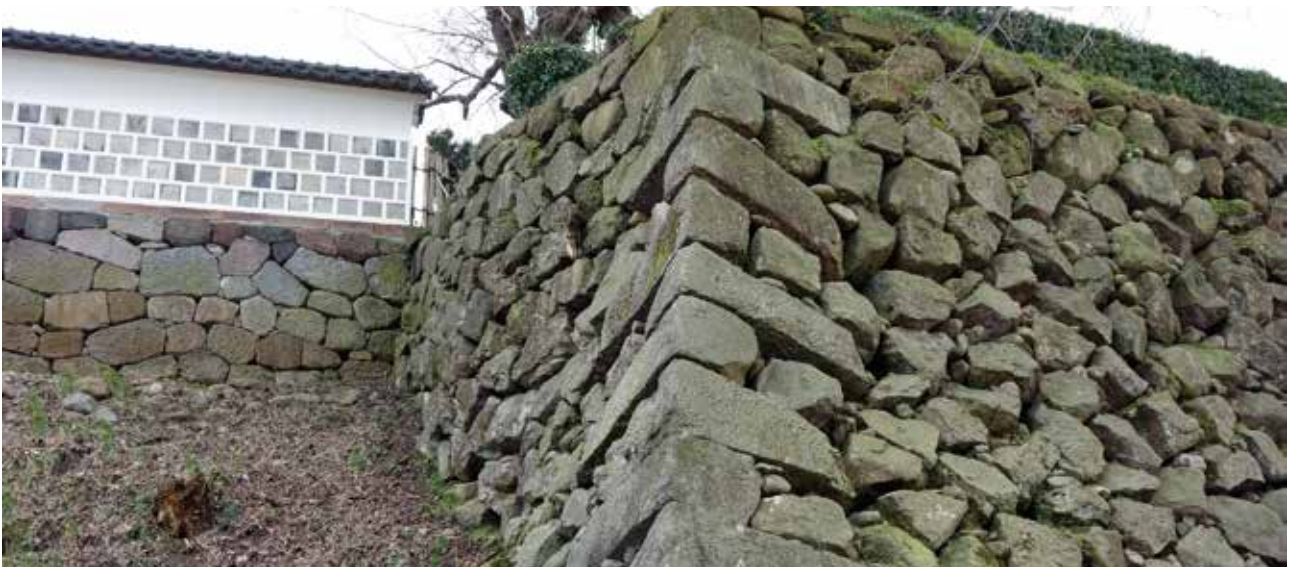
5 3440E 北東から
