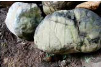
変形箇所前面の盛土が流れ、根石が露出 (a)
