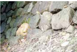
現況最下部 (根石か) の石が斜面方向に滑る (b)
