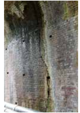
トンネル内部の亀裂と漏水
