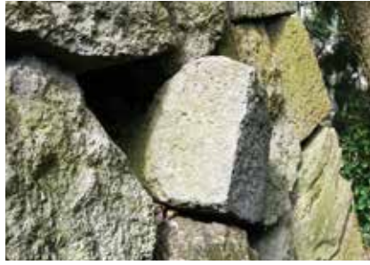
築石が大きく迫出す。上部・左右の石とかみ合わせが効いておらず、自重のみで保っている状態（南から）
