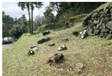
2010年3月に左上部が9石転落 オーバーハングした崩壊崖を整形し、 土嚢詰めとシートで応急養生
