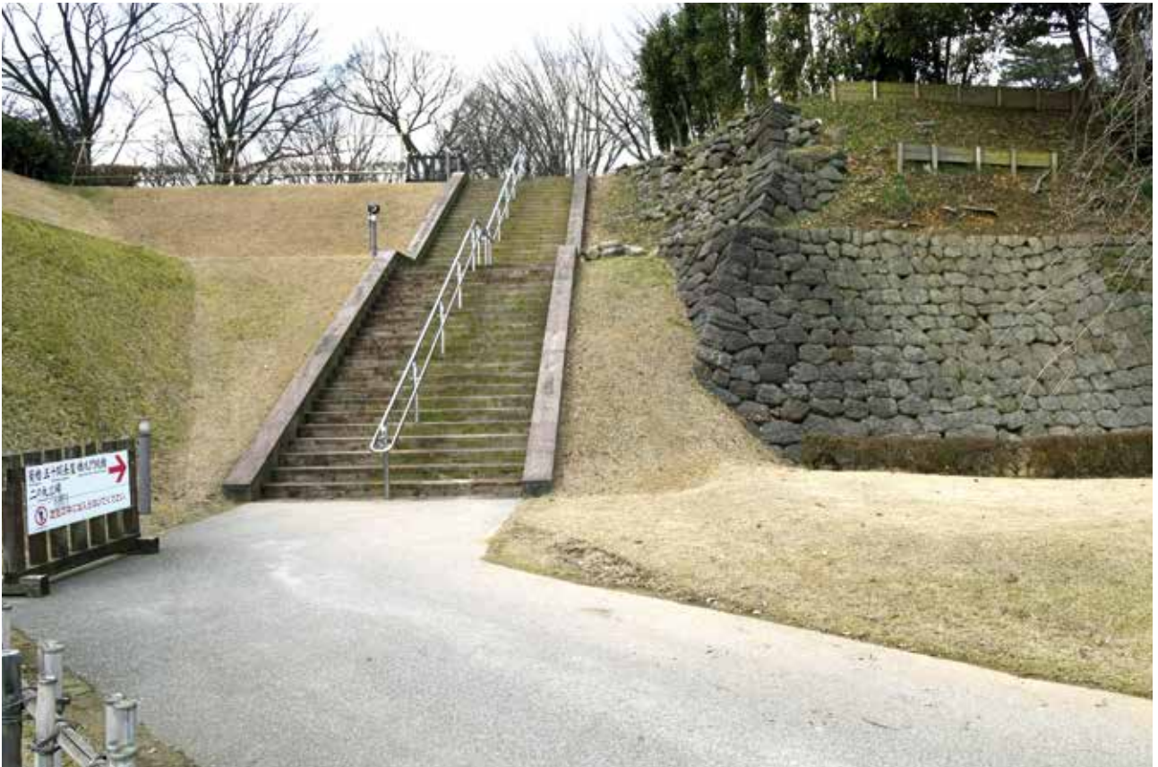
1 5001～3S、5002・3E 東から
