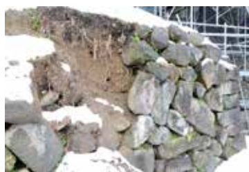
2010年破損箇所の右側が 2012年1月に約1m 3 (10石)破損
