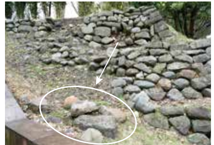
築石の崩落位置は不明。他の場所に転落し、その後、集積された可能性がある
