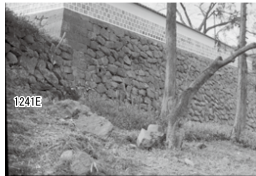
昭和28年 (石積みは現況と一致する 石材が前方に散らばる) 独立行政法人国立文化財機構奈良文化財研究所提供
