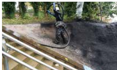
写真5 No. 26 石垣法面保護措置
