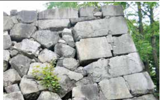
檜台部に大火に伴う被熱痕跡。石材の剥離、鉛瓦が溶けた鉛の融着
