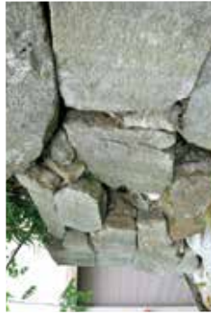
石垣全体が緩んだ状態であり、天端石が後ろにひっくり返る
