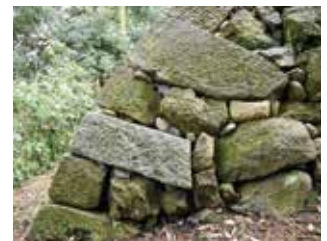
隅角部等の詰石補強後の状況 河原石及び戸室石の割石を使用
