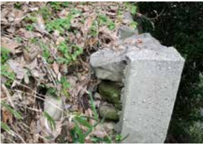
背面盛土の一部が流出しており、石の控えが露出
