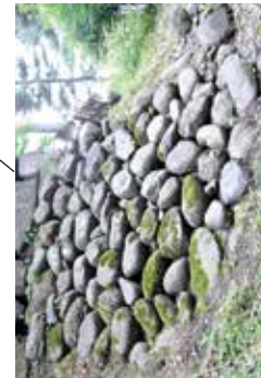
石垣前方の斜面に自然石の石積み
