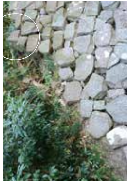
築石部が途切れ、背面の露出や築石間の目地の開き等、不安定な状態
