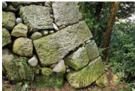
詰石補強後、河原石と戸室石の割石を使用
