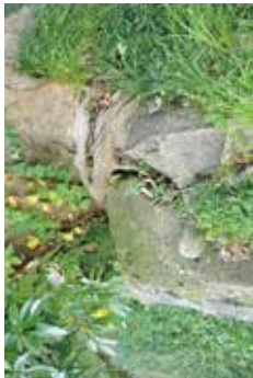
エノキ 樹高13m、幹回り2.1m 天端直上に位置 樹木根により天端石が上がる
