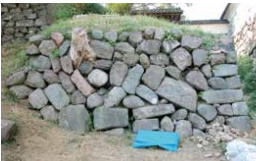
崩壊前 上部 2/3 は小型石材を多用 H14 年度に近接地の発掘調査で 近代以降の石垣と確認
