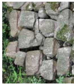
築石部が途切れ、背面の露出や築石間の目地の開き等、不安定な状態
