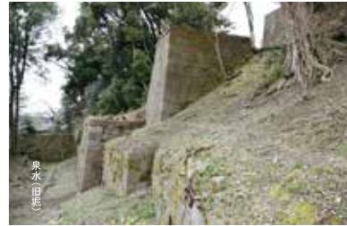
写真10 玉泉院丸北泉水縁石垣
