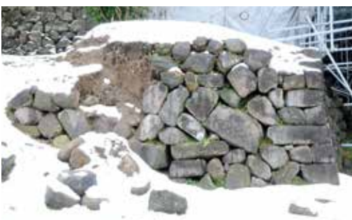
2010年破損箇所の右側が 2012年1月に約1m 3 (10石)破損
