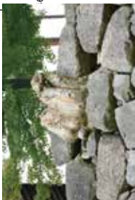
樹木根が入り込み天端石を 持ち上げる
