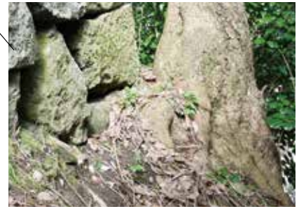
隅角部に近接した樹木。地盤・石積みの安定性に寄与している可能性がある
