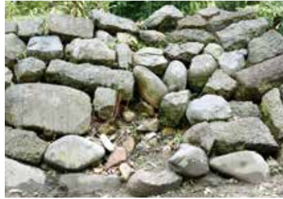
築石（4石）崩落后、裏込め等が露出 2014年10月末以降に崩落
