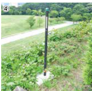
孔内傾斜計計測管設置状況
