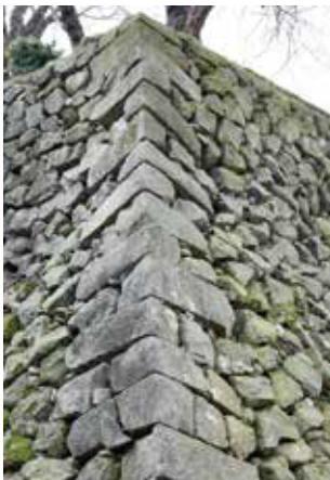
6. 三ノ丸北（九十間長屋下） 北東 3440N・E
