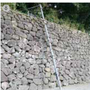
多点式変位計設置状況
