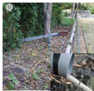
伸縮計設置状況
