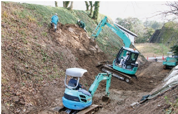
2008-2地点 埋め戻し作業
