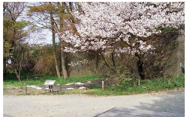
本丸附段調査区 本丸西面石垣 南西から
