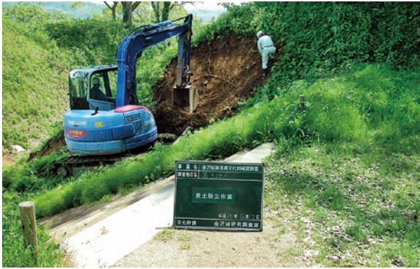
2006-3地点 表土除去 西から
