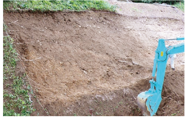
2008-1地点 表土除去 北東から
