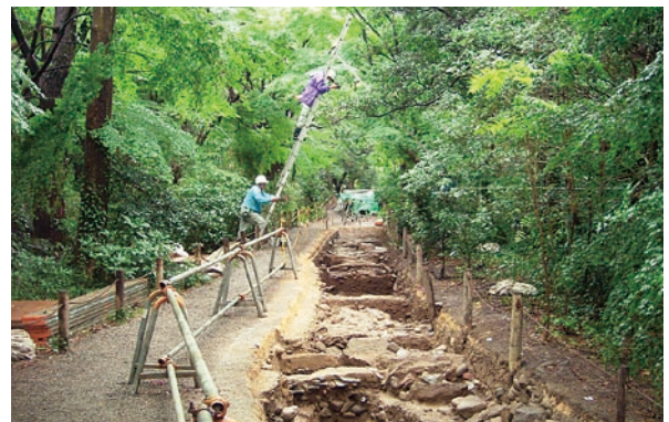
測量作業風景 (本丸南東部調査区)
