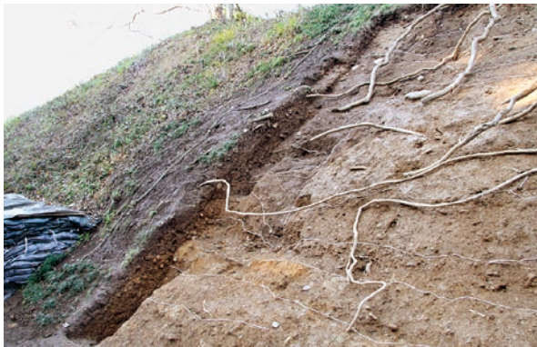
2008-2地点 調査地点西壁
