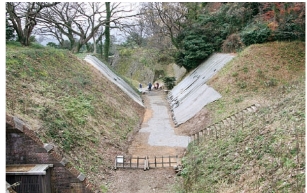
2008-1・2008-2地点 埋め戻し完了状況
