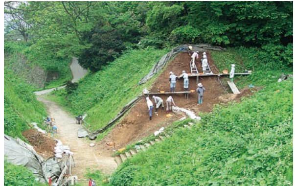
2006-3地点 斜面精査 西から
