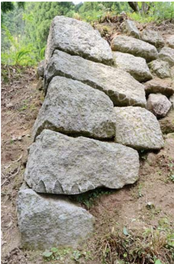
4 SW1南東隅角部（東面）
