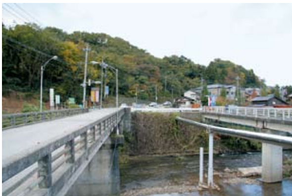
7 浅野川越に架かる田上橋 (田上町地内)
