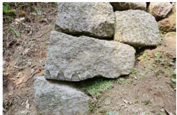
6 三角形矢穴痕が残る角石の割面
