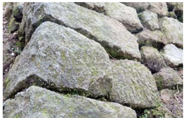
5 隅角部の石材加工（角石：割、角脇石：ツル）
