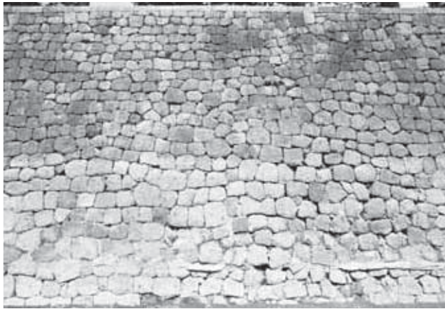
口面 3 (五十間長屋南半東面 2120E)
