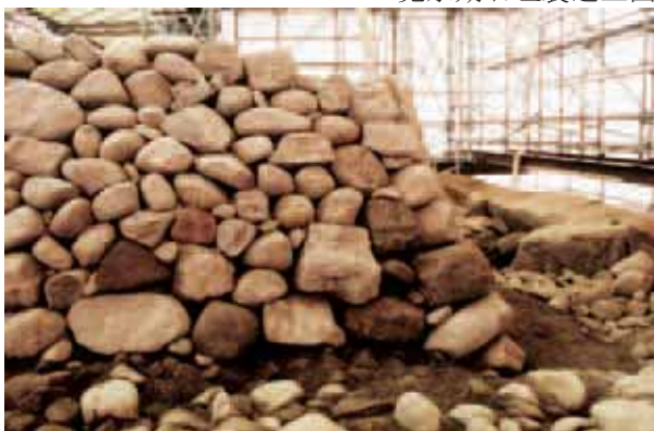
橋爪門統櫓台石積遺構 1 南面東端・寛永期石垣裏込上面
