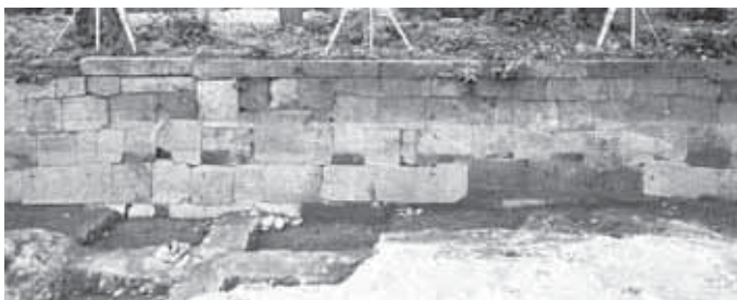
チ・ワ面6 (五十間長屋南半西面 2120W)
