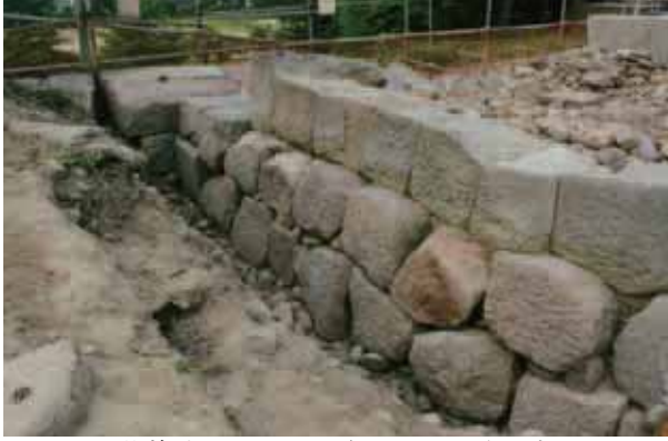
菱櫓台石垣西面（才面2140W）下部
