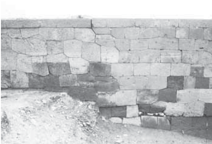
チ・ワ面10 (五十間長屋南半西面 2120W)
