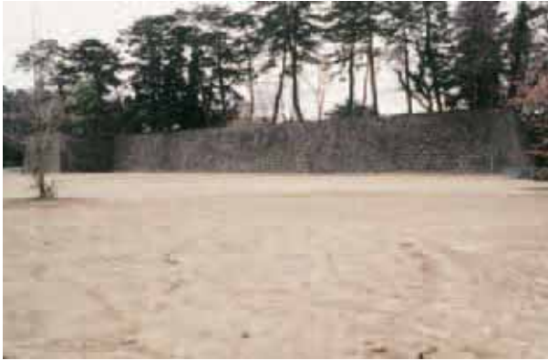
内堀中央部・櫓（長屋）台 調査着手前 東から
