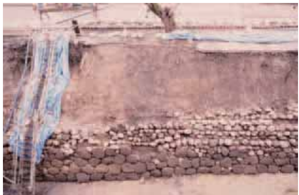
内堀西部北岸（石垣 2210S） 12
