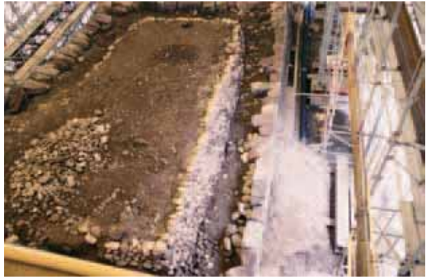
橋爪門続櫓台石積遺構 1 全景 西から
