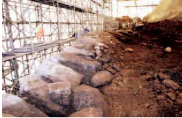
石垣解体作業風景
