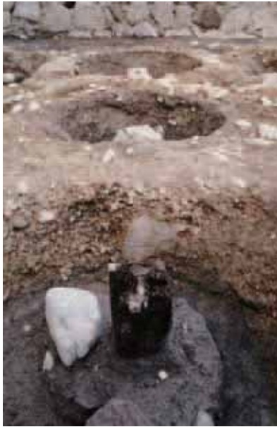
内堀橋 P4～P6 (橋脚基礎列中央) 南から
