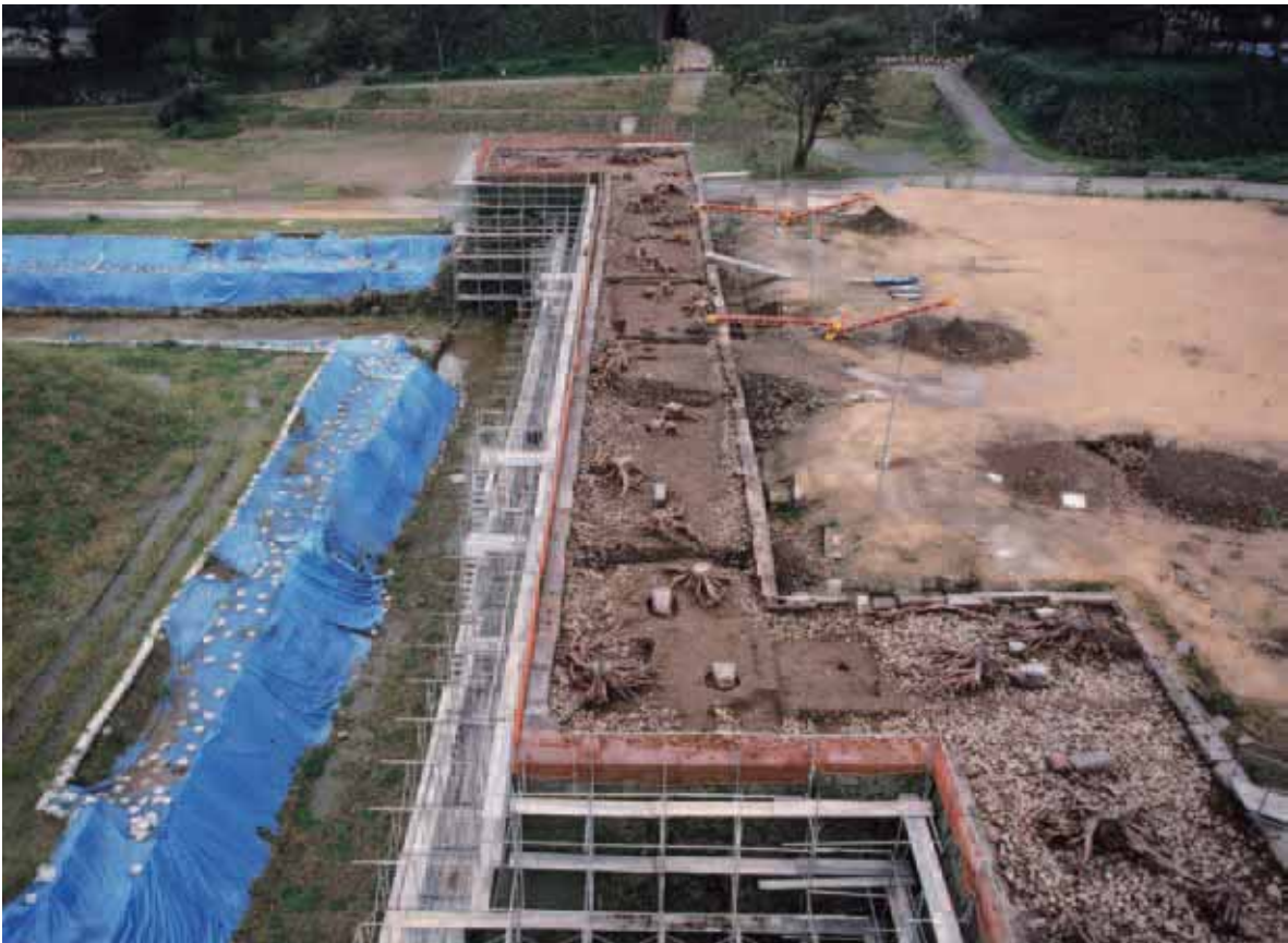
五十間長屋・橋爪門続櫓 北から
