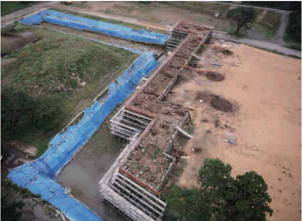
菱櫓・五十間長屋・橋爪門続櫓台 全景 北西から
