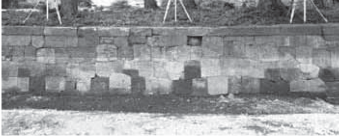
チ・ワ面8 (五十間長屋南半西面 2120W)
