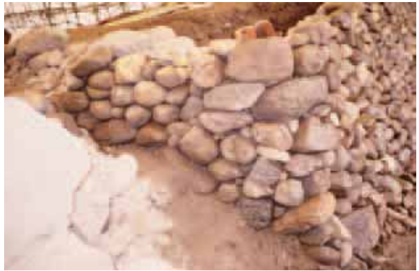
橋爪門統櫓台石積遺構 1 西面
