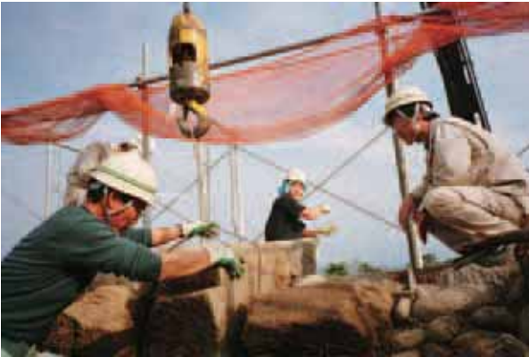
石垣解体作業風景
