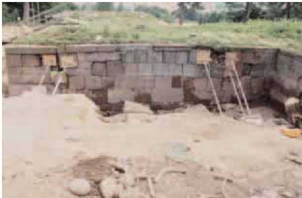
櫓（長屋）台取付階段② 五十間長屋(東西部) 南から
