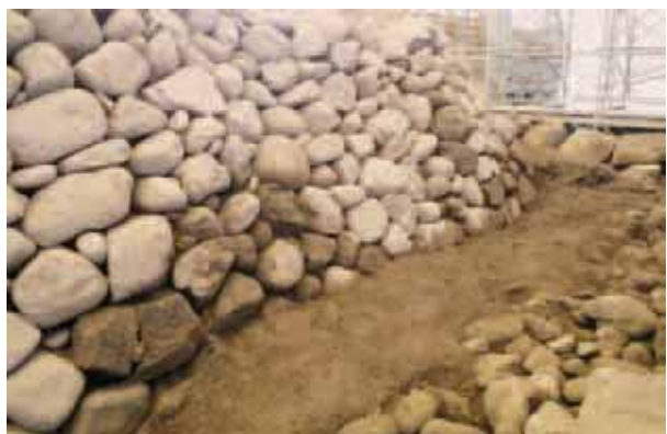
橋爪門続櫓台石積遺構 1 東面北側・ 文化期修築作業面
