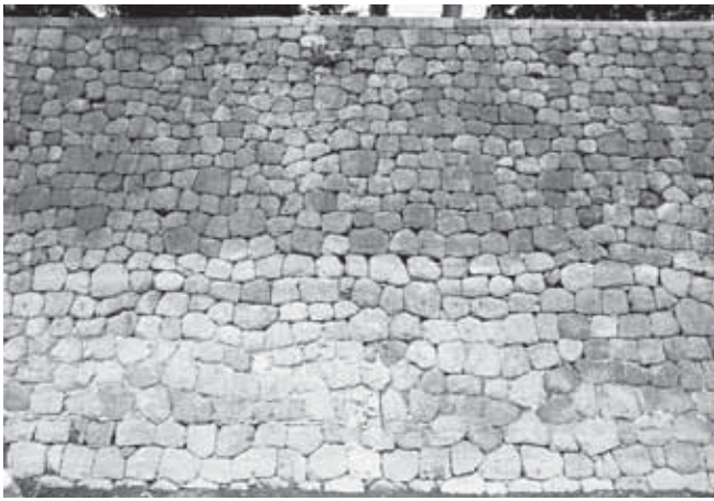
口面 2 (五十間長屋南半東面 2120E)
