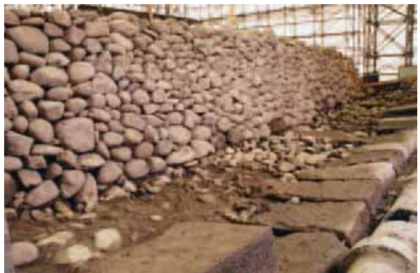
橋爪門統櫓台石積遺構 1 南面・寛永期石垣裏込上面
