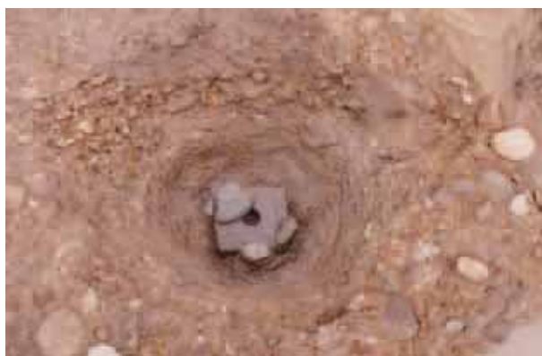
内堀橋 P 5 第1段階橋脚礎盤（根石）
