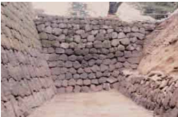
裏口門土橋石垣東面 (2210E)
