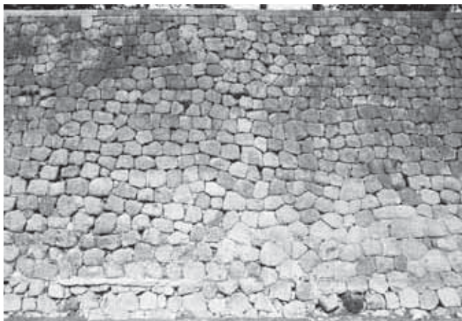
口面 4 (五十間長屋南半東面 2120E)
