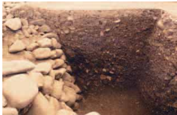
橋爪門統櫓台南北土層断面 SP11 L=45.4_44.4m付近西壁 (石積遺構 2)
