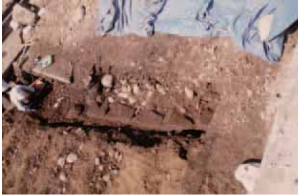
二ノ丸階段西側石垣台下部 東から
