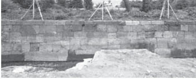
チ・ワ面2 (五十間長屋南半西面 2120W)
