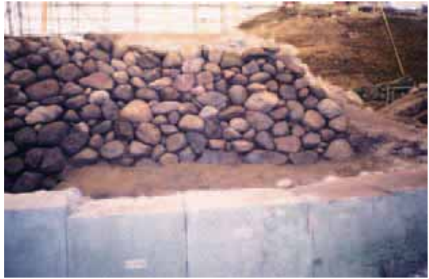
橋爪門統櫓台石積遺構 1 東面北側
