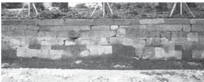
チ・ワ面7 (五十間長屋南半西面 2120W)
