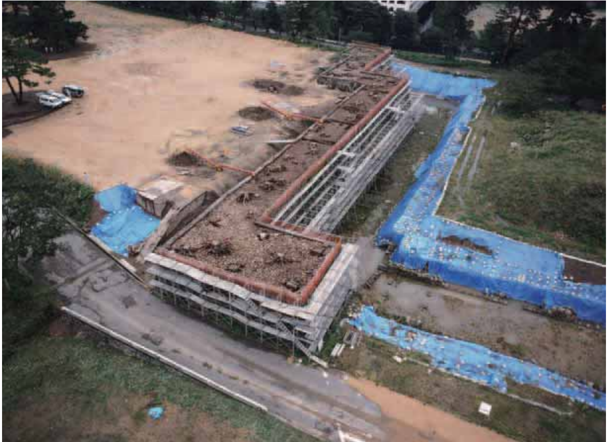
菱櫓・五十間長屋・橋爪門続櫓台 全景 南東から
