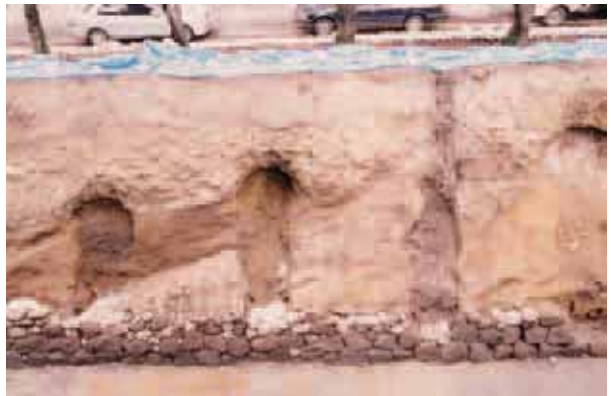
内堀西部北岸 (石垣 2210S) 2
