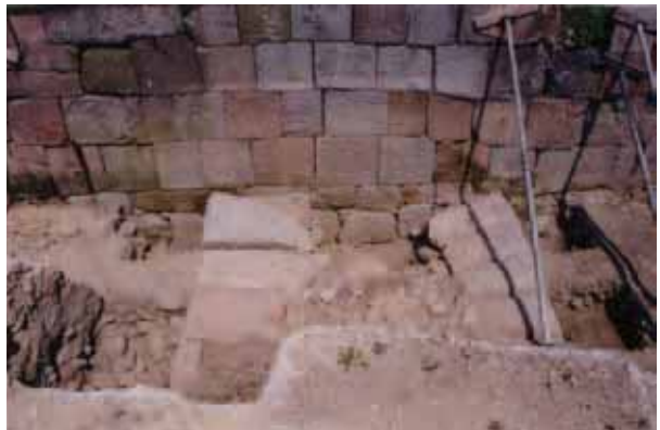
櫓（長屋）台取付階段② 五十間長屋(東西部) 南から
