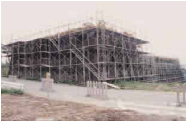
櫓（長屋）台足場設置 南から
