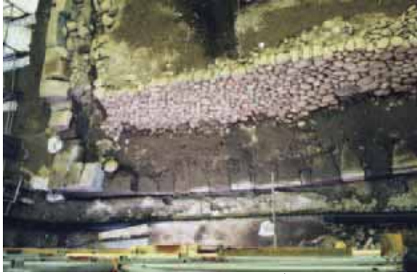
橋爪門統櫓台石積遺構 1 南面西側・文化期修築作業面
