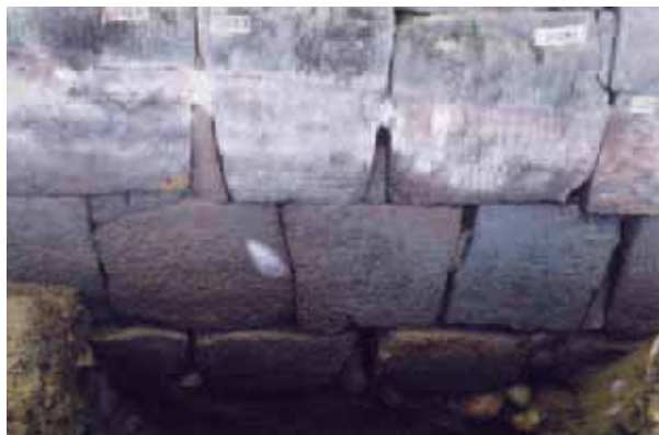
橋爪門続櫓台石垣南面（卜面2110S）下部根石付近 根石確認トレンチ
