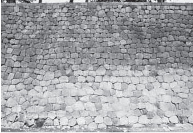
口面 5 (五十間長屋南半東面 2120E)
