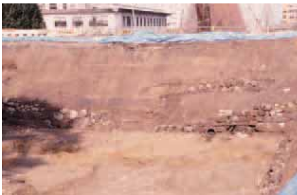
内堀西部北岸（石垣 2210S） 13
