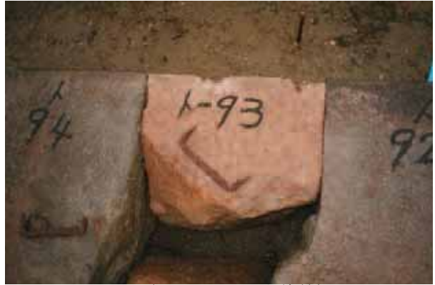
卜面 (2110S・文化期修築) 卜93・94上面敷金
