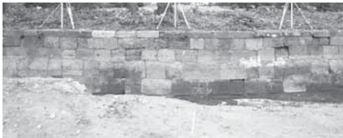
チ・ワ面4 (五十間長屋南半西面 2120W)
