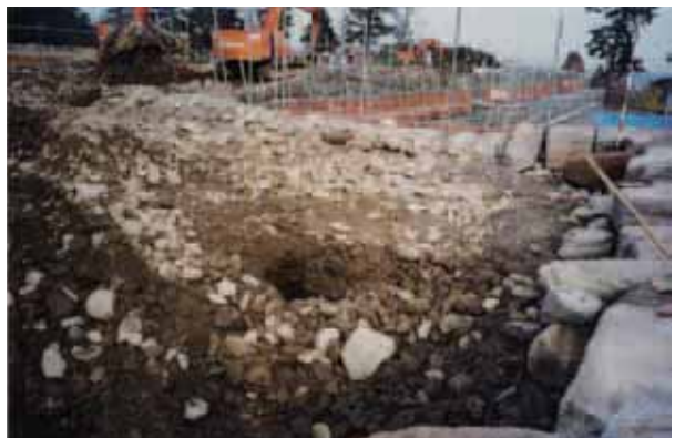
橋爪門続櫓台 陥没坑検出状況
