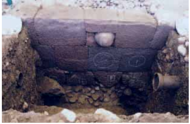
五十間長屋台石垣西面（才面2120W）下部 SP9付近 根石確認トレンチ北
