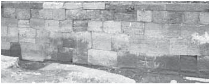
チ・ワ面3 (五十間長屋南半西面 2120W)
