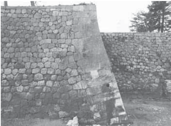
口面 7 (五十間長屋南半東面 2120E ～北)
