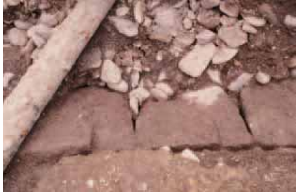
二ノ丸階段西側石垣台下部 東から
