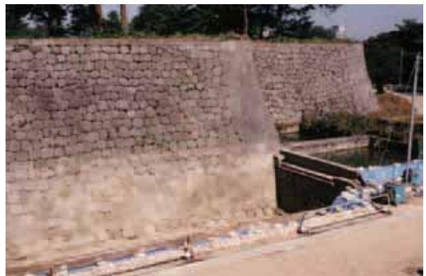
五十間長屋台石垣と水槽 ST 8 遠景 東から
