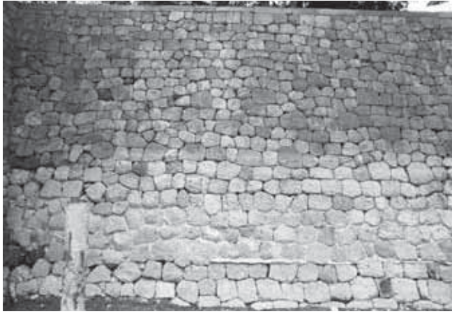
口面 1 (五十間長屋南半東面 2120E 南～)
