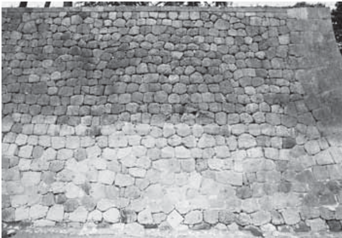
口面 6 (五十間長屋南半東面 2120E)
