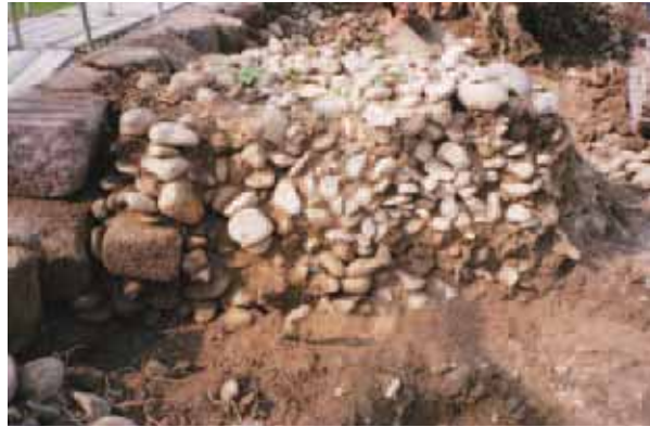
橋爪門続櫓台南北土層断面 SP11 L=50.4_49.3m付近西壁南側
