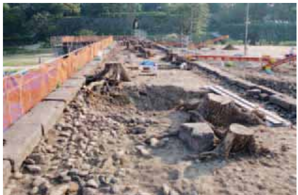
五十間長屋 作業風景 北から
