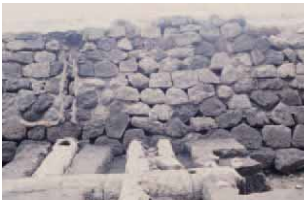
近代石垣 SW 2 西から
