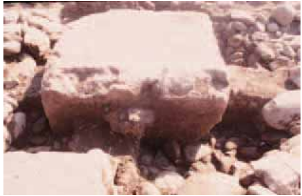
橋爪門続櫓 礎石 I 北から
