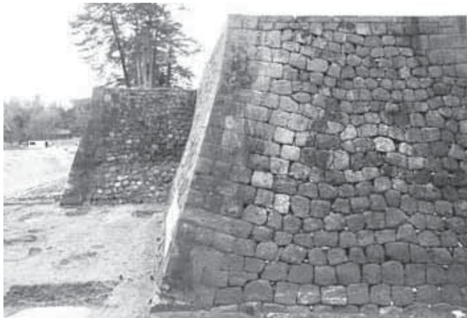
北面 (菱櫓北面 2140N) 北面 (五十間長屋北半北面 2130N)
