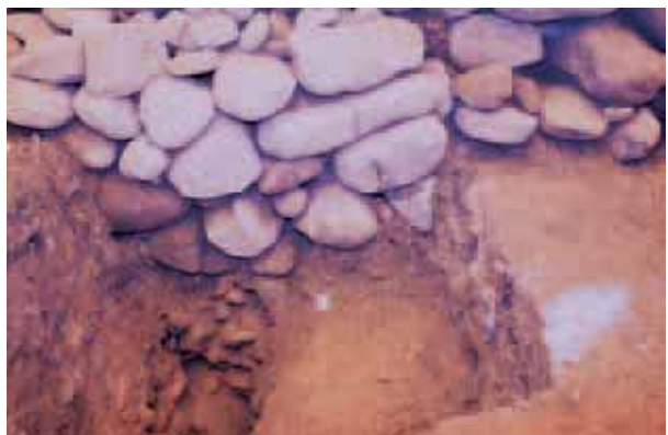
橋爪門統櫓台石積遺構 2 南列中央下部 北から
