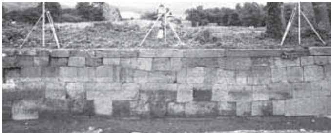
チ・ワ面5 (五十間長屋南半西面 2120W)
