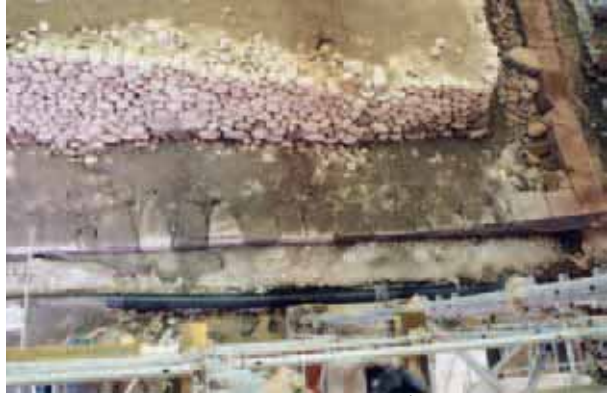
橋爪門統櫓台石積遺構 1 南面東側・文化期修築作業面
