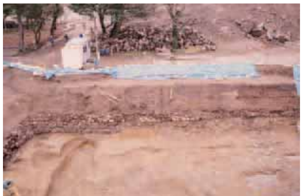
内堀中央部東岸（石垣 2220W）
