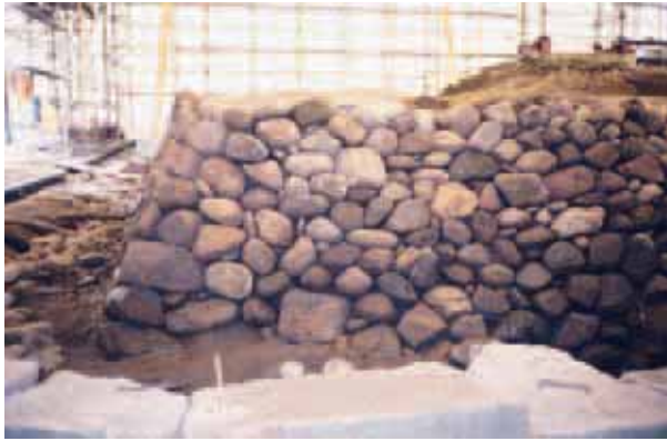
橋爪門統櫓台石積遺構 1 東面南側
