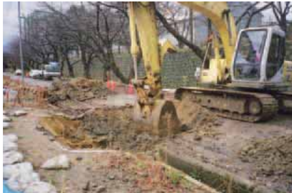
三ノ丸第3次調査区 表土除去 西から
