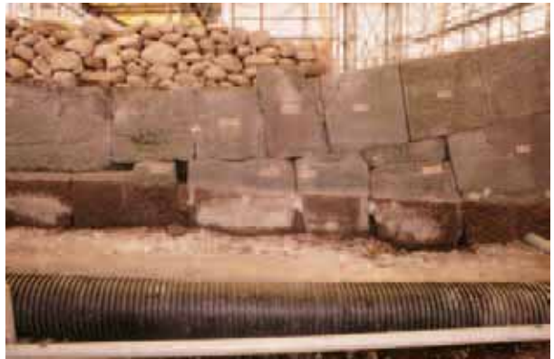
橋爪門続櫓台石垣南面（卜面2110S）下部
