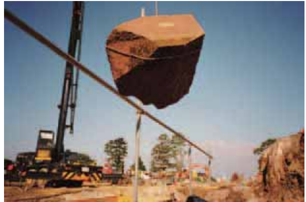
石垣解体作業風景
