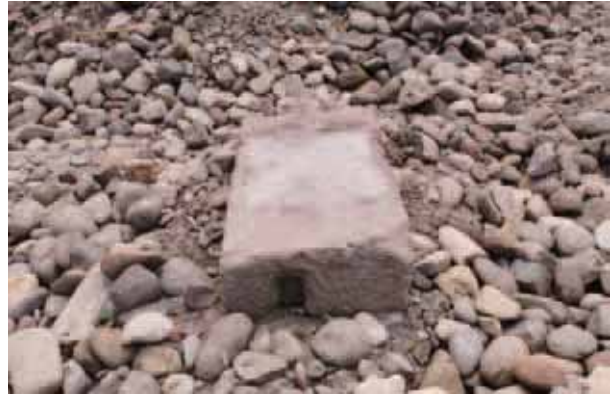
五十間長屋 古段階礎盤(根石)エ 北から
