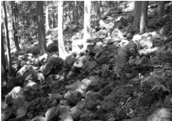
C地区石材清掃作業（南西から）
