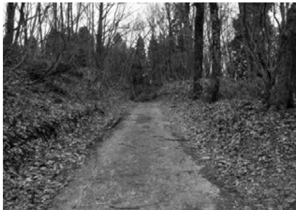
石引道（左側の段差が旧路面）
