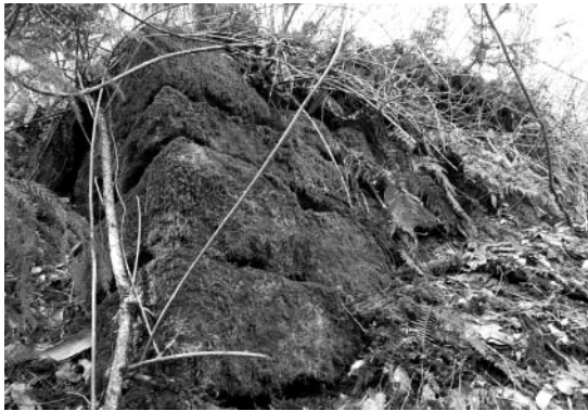
採掘坑群前面の平坦面に伴う石垣
