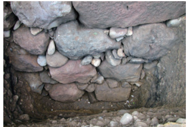
2002-9地点 石垣立面 (1110N)
