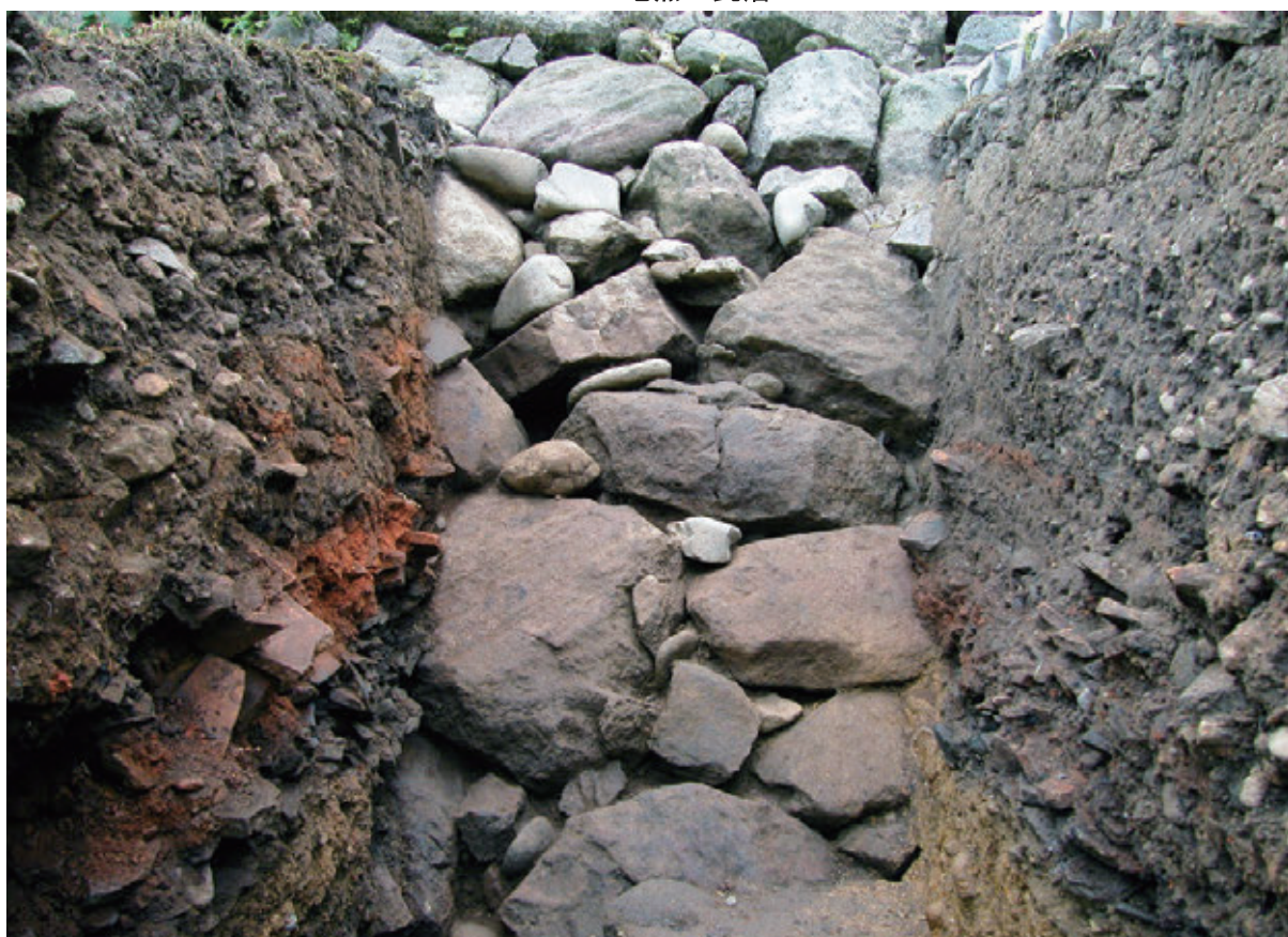
2002-7地点 石垣立面(1110N)
