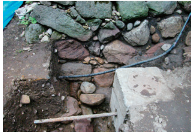
2003-3-2地点 石垣立面(1200E)
