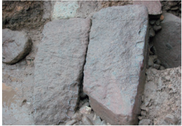
2002-34・35地点 第Ⅱ段階側壁石垣
