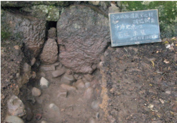
2002-34・35地点(西) 石垣立面(1300N)
