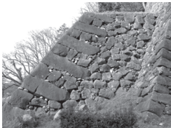
辰巳櫓下石垣（1140E 右1131S・E）
