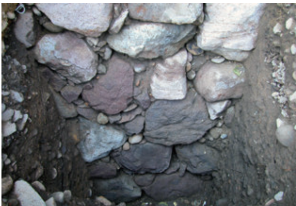
2002-8地点 石垣立面 (1110N)
