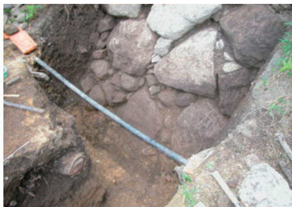
2002-4地点 石垣立面(1121N)
