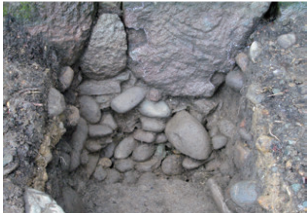
2002-34・35地点(西) 石垣(1300N)基礎
