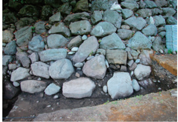
2002-17地点 石垣立面(1220E・1221E)
