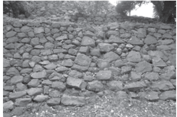
丑寅櫓東側石垣（下段から1220E、1210E、1121E）
