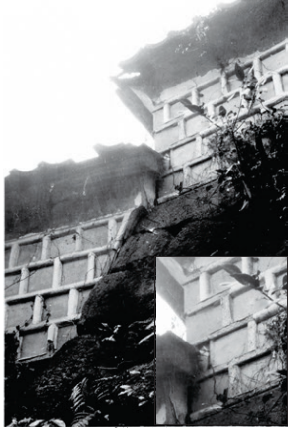
②檜台（東部） 海鼠塀の漆喰は上塗りのみ
