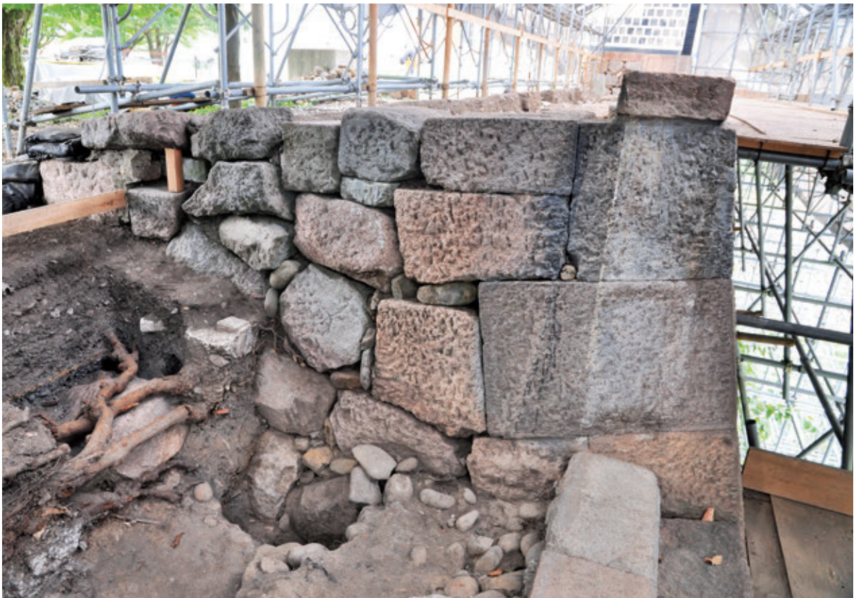
1区 三ノ丸東石垣 南から
