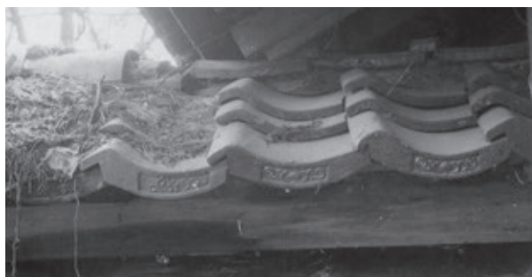
昭和保存修理工事前の屋根瓦
