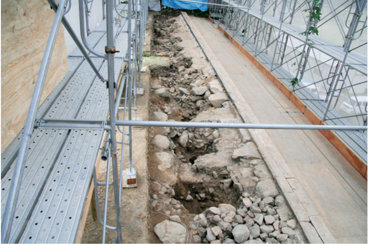
1区 控柱抜取痕完掘状況 東から
