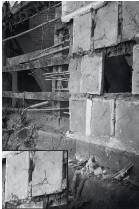
④二ノ門脇（外側） 腰瓦は貝折れ釘にて留められている
