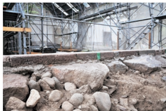
4区 基礎石（11～13）刻印 北から
