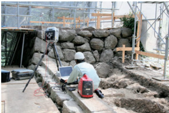
4区 三ノ丸北東(隅櫓台)石垣測量 北から
