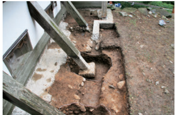
4区 コンクリート製控柱掘方掘削状況 東から
