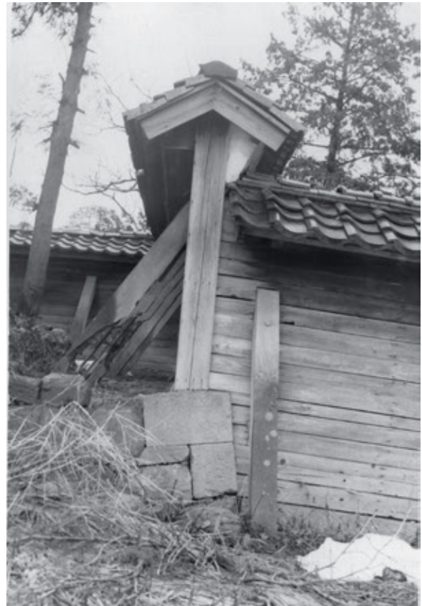
⑪水ノ手門・右塀上下の取付き
