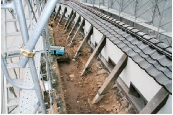
2区 コンクリート製控柱掘方検出状況 東から
