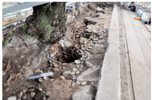
2区 排水溝（昭和保存修理）検出状況 南から
