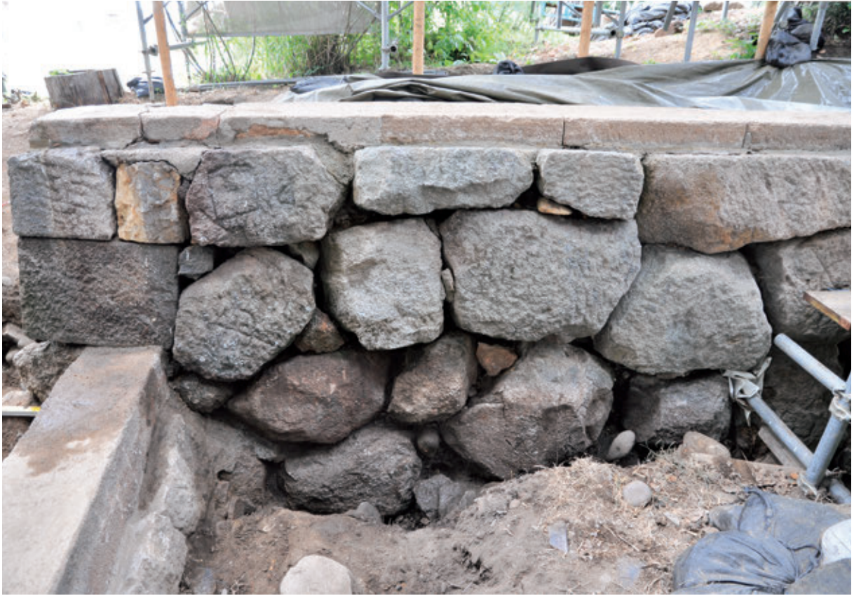
4区 三ノ丸東（太鼓塀下）石垣 南から
