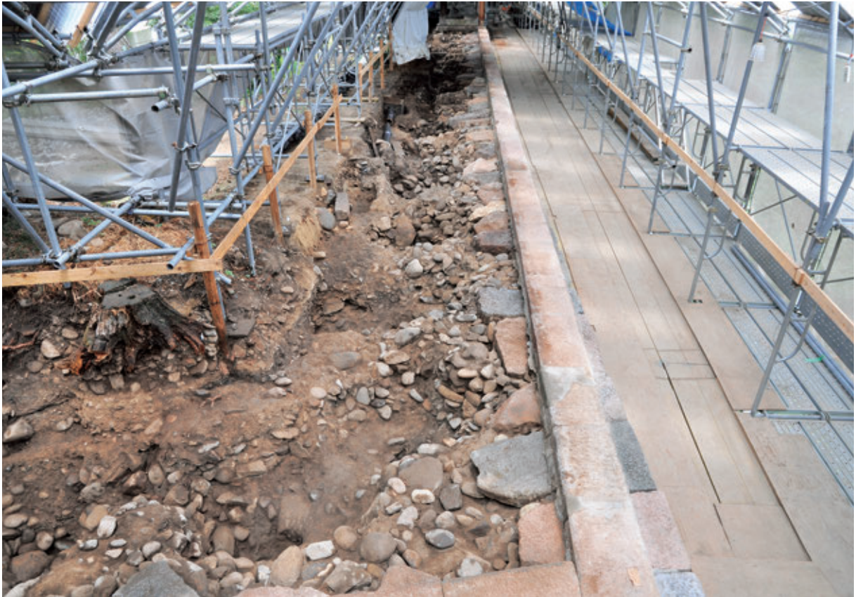
3区 控柱抜取痕完掘状況 南から
