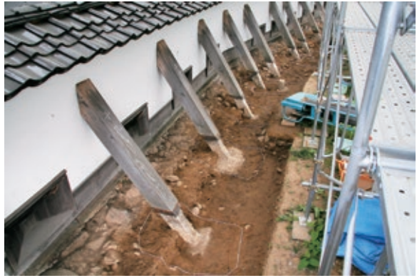
2区 コンクリート製控柱検出状況 西から
