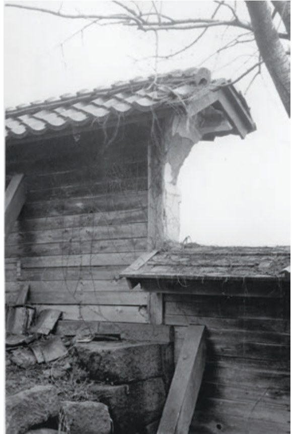
⑨三ノ丸東石垣 塀上下の取付き
