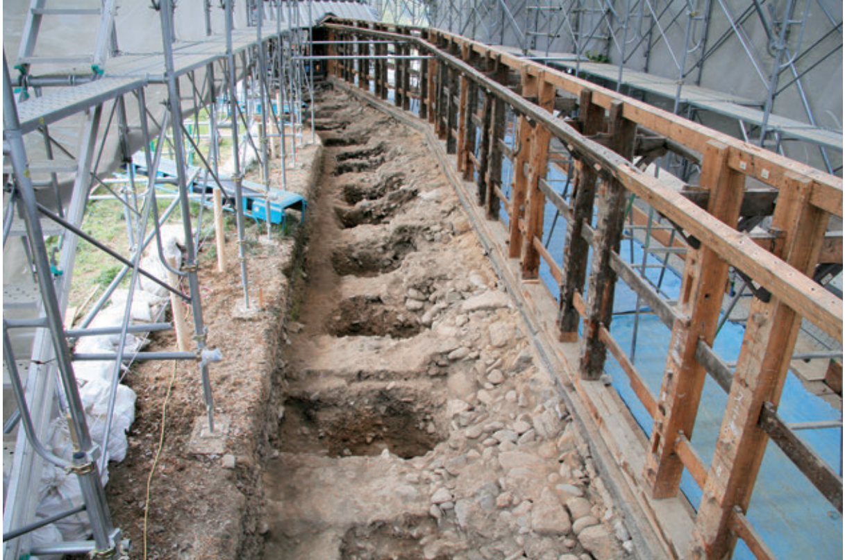
2区 控柱抜取痕完掘状況 東から
