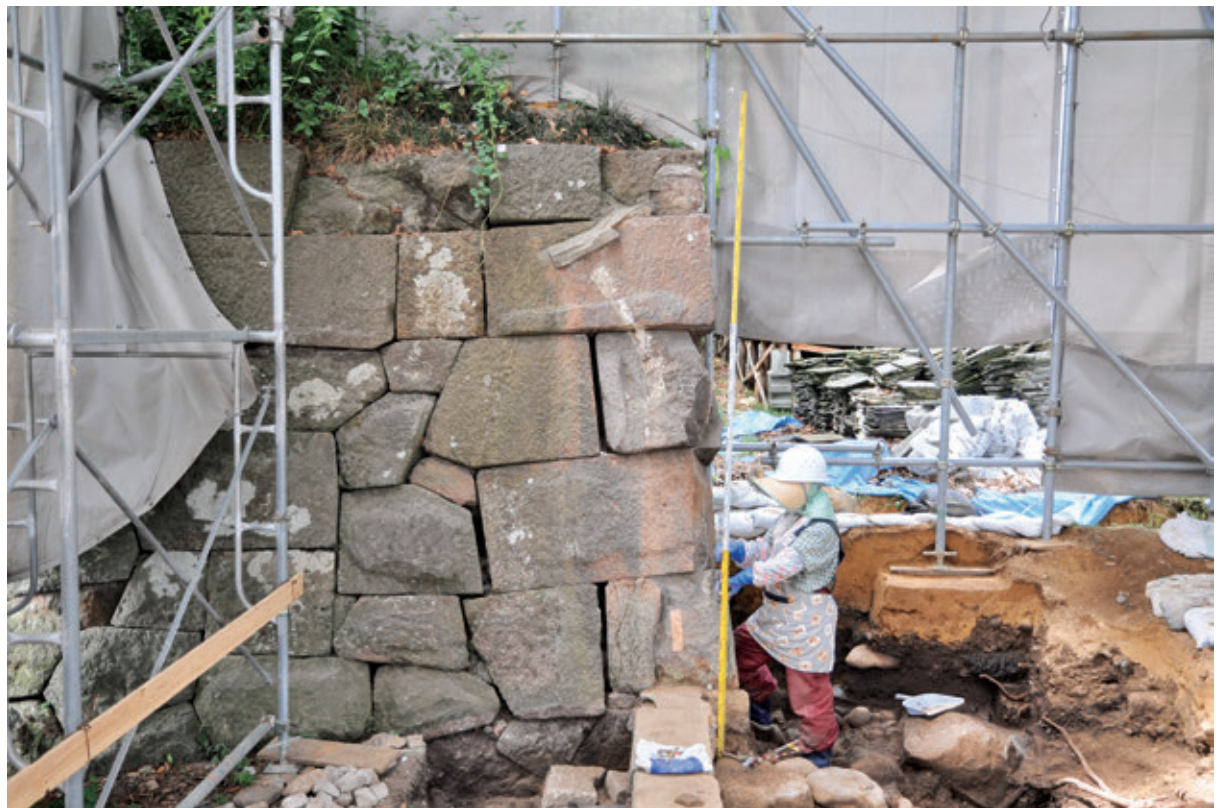
5区 東ノ丸東（丑寅櫓下・東2）北面石垣 北から
