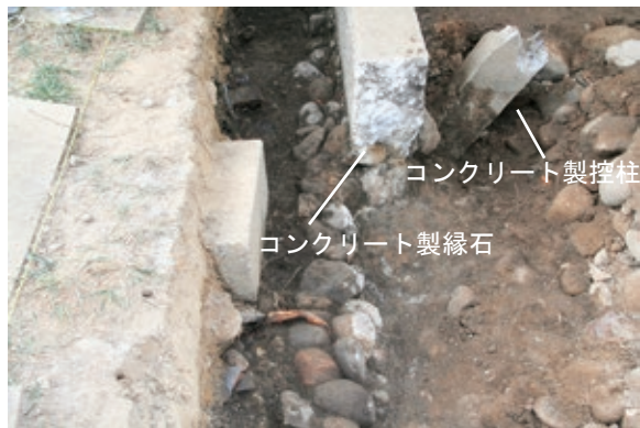
コンクリート製控柱・縁石解体中 南から
