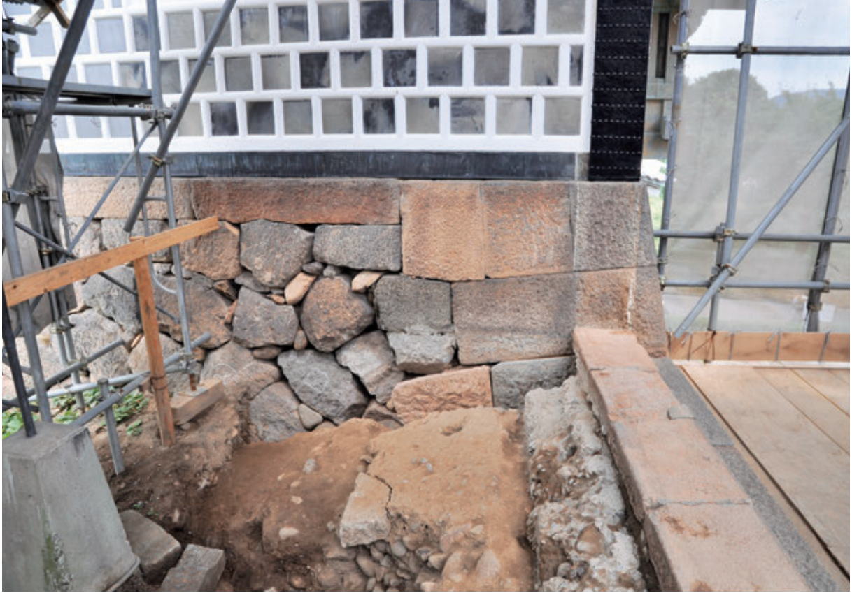
1区 石川門続櫓台石垣 南から
