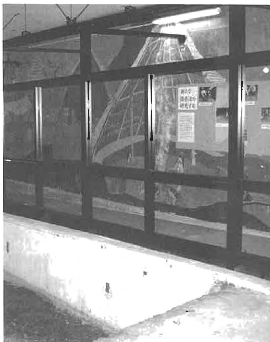
図1 交換されたガラスフェンス
