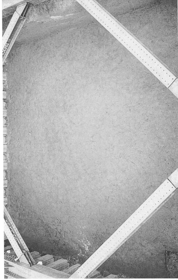
a 1Bトレンチ III-2層上面 全景(南より)
