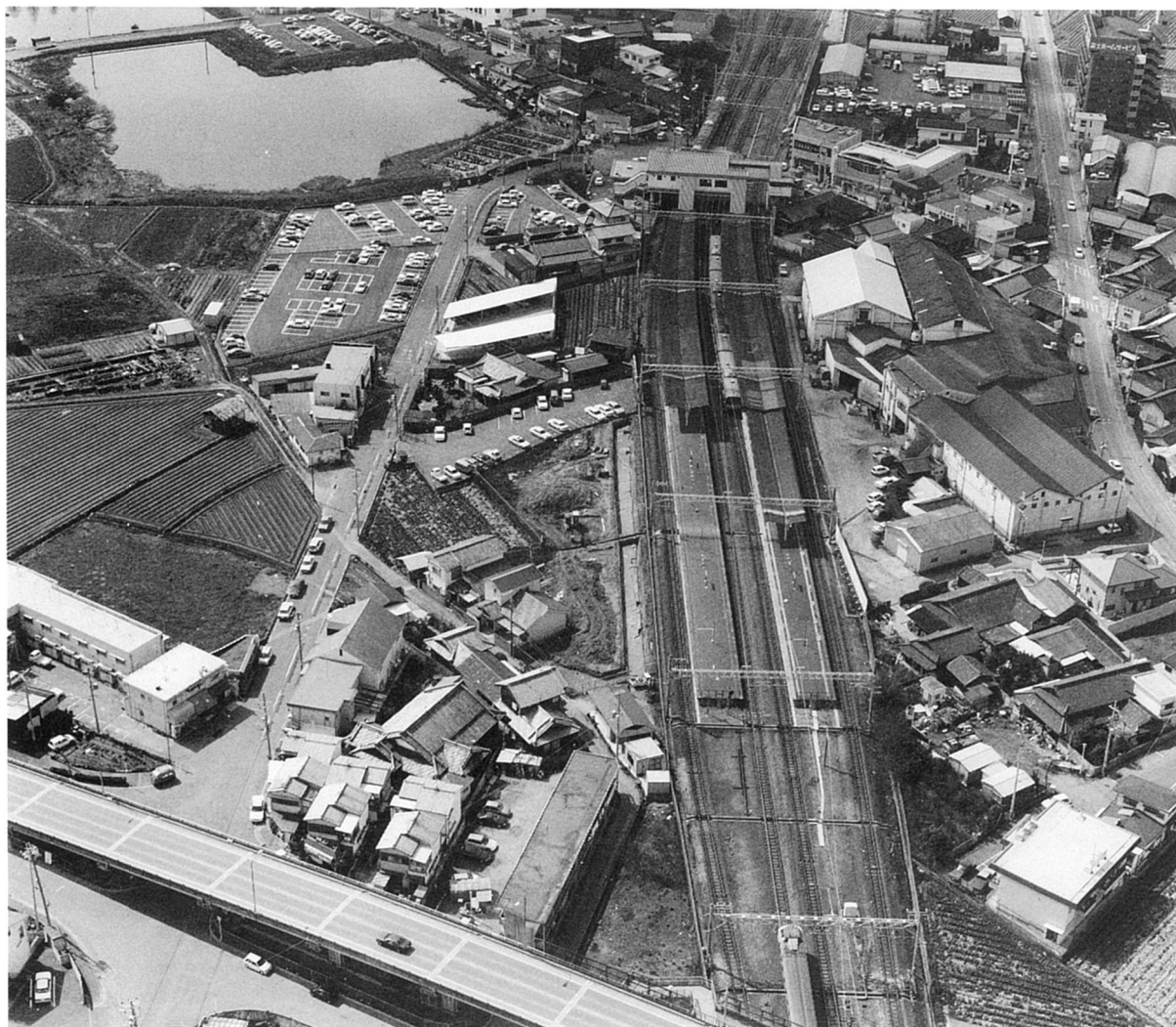
日根野跨線橋上空より調査区・JR日根野駅・白水池を望む (北東→南西)
