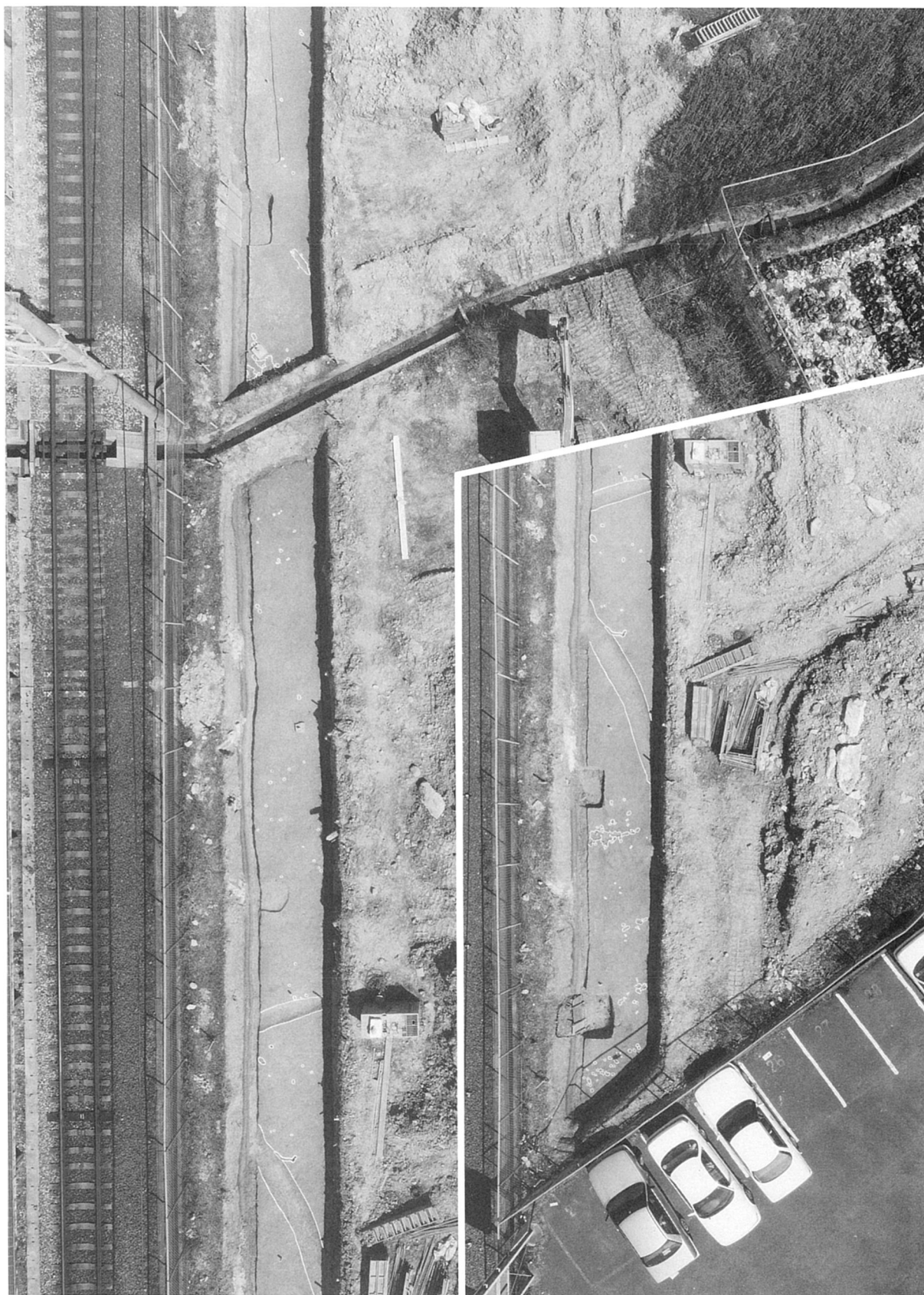
3 A区 垂直写真 (南西→北東)
