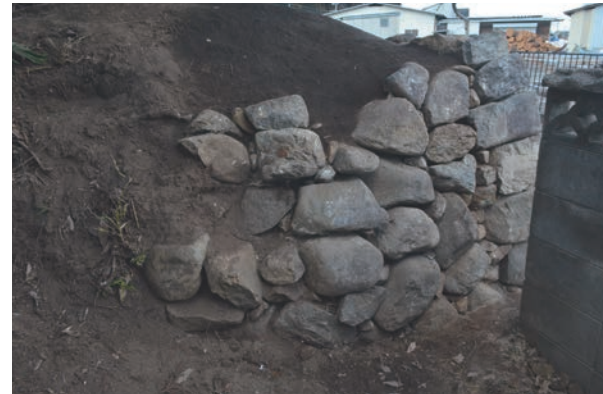
写真 22 復元完了（南面）
