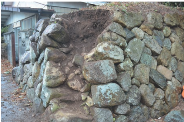
写真5 石取り上げ後状況1
