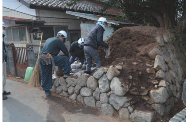
写真 18 復元作業状況 1
