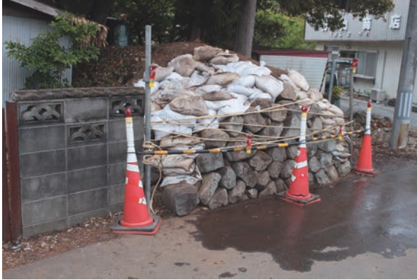
写真 17 応急措置状況
