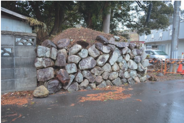
写真1 宮城県沖地震被害状況（東面）
