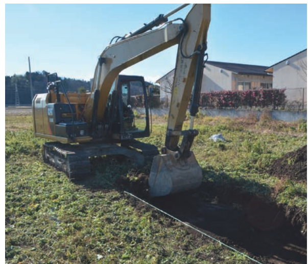
写真74 重機掘削状況
