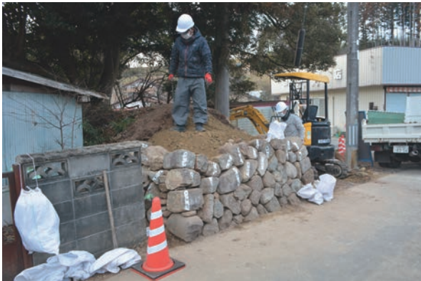
写真 21 復元作業状況 4
