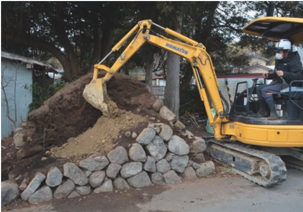
写真 19 復元作業状況 2
