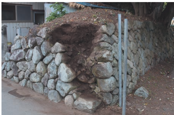
写真7 石取り上げ後状況3
