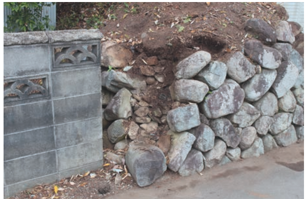
写真6 石取り上げ後状況2
