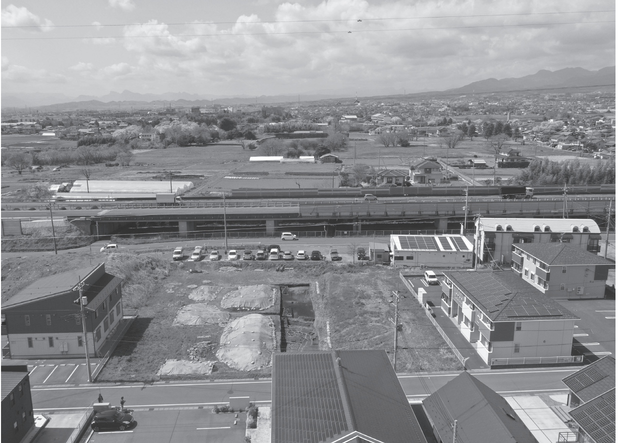
調査区遠景（東から：奥に上野国分寺跡）
