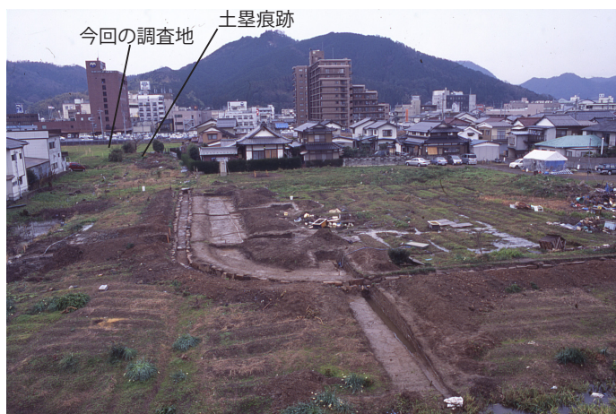
写真3. 第25次調査全景（東から）
