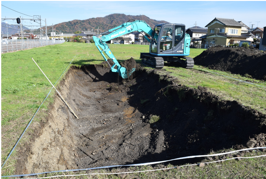
重機掘削状況 (南から)
