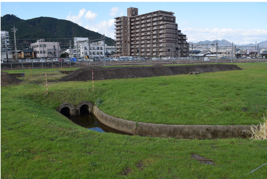
調査区とコモ池川暗渠 (東から)
