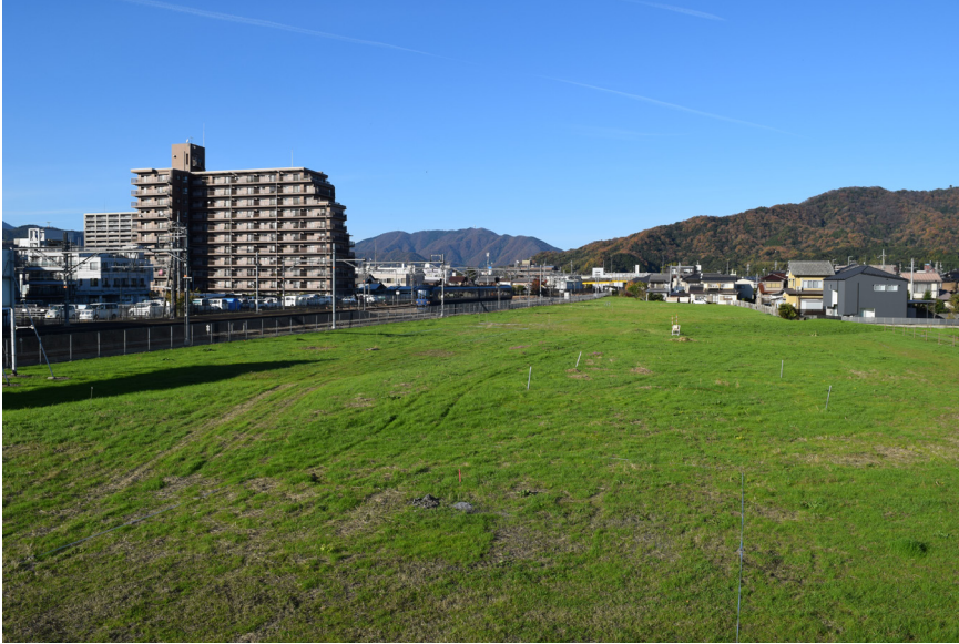
調査前遠景 (南から)
