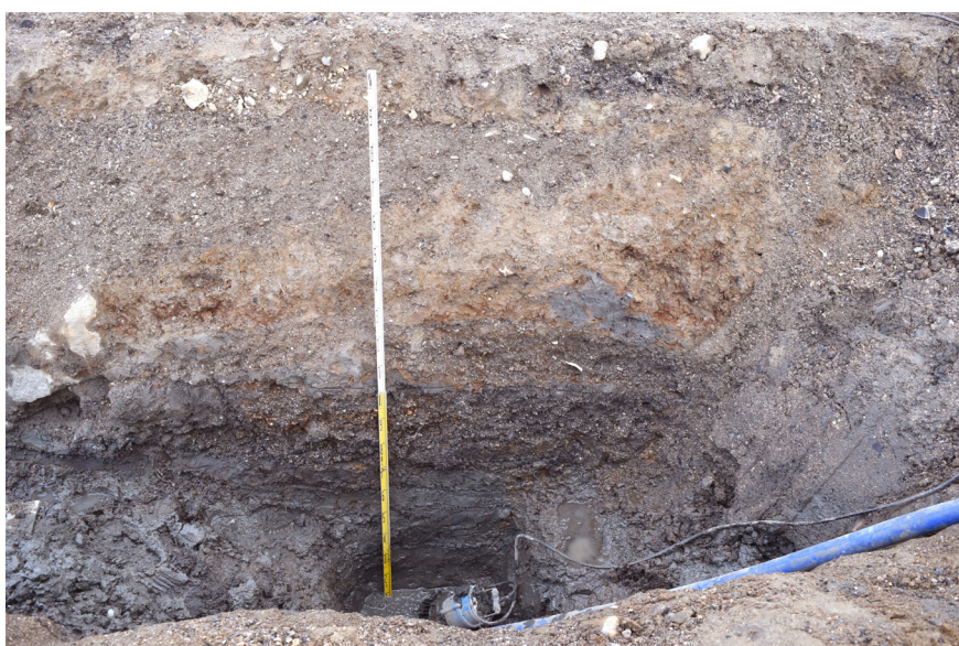
北区南側中央断割 深掘り部分（西から）
