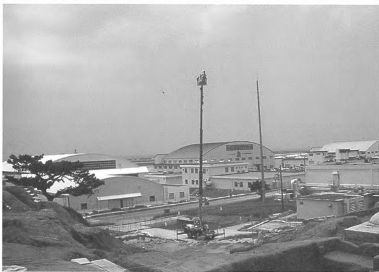
図版4 発掘調査の様子 上：遺構実測作業 下：遺構俯瞰写真撮影
