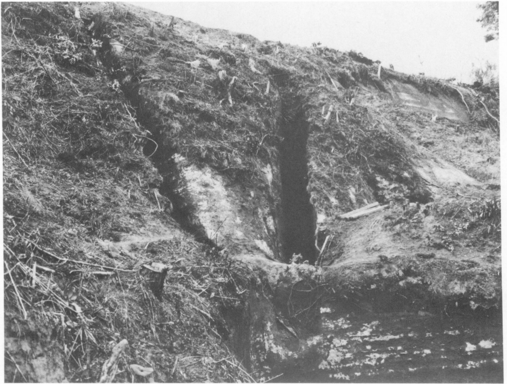
市原市養老藤原式揚水車 | 号機揚水用施設
