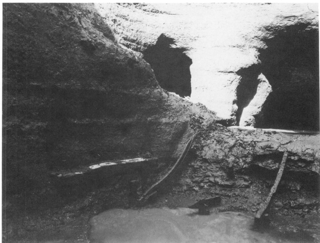
市原市養老藤原式揚水車 2号機動力部北側
