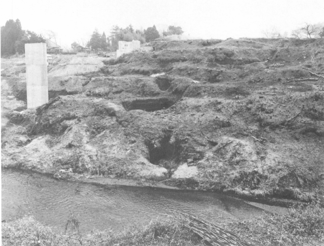
2. 市原市養老藤原式揚水車2号機近景（調査前）
