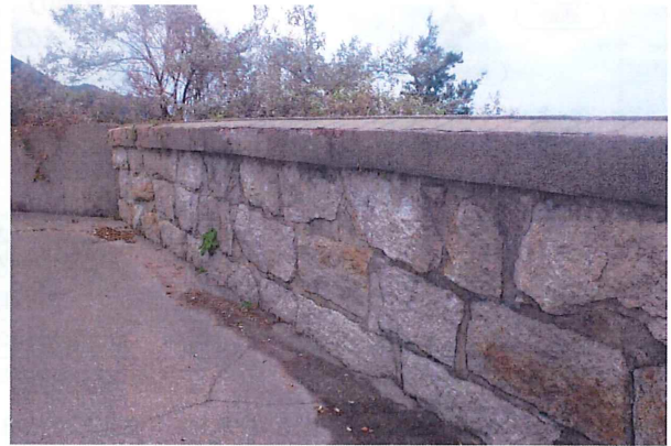
写真 20. 屋久島灯台石塀
