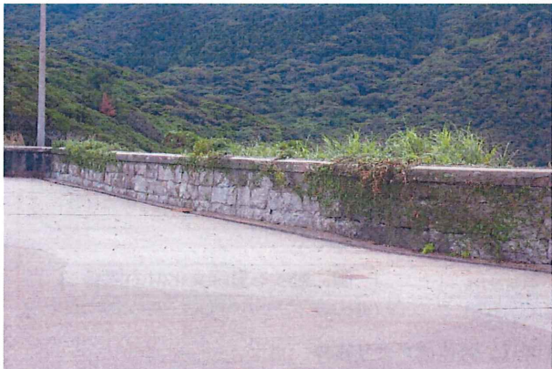
写真 19. 屋久島灯台石塀
