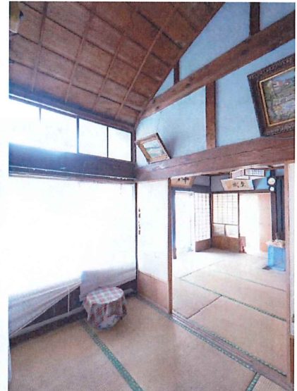
写真 16. 曲線を描く吹抜け天井
