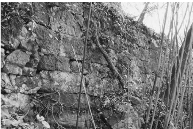
(7) (6) 左下の石垣 (南東から)
