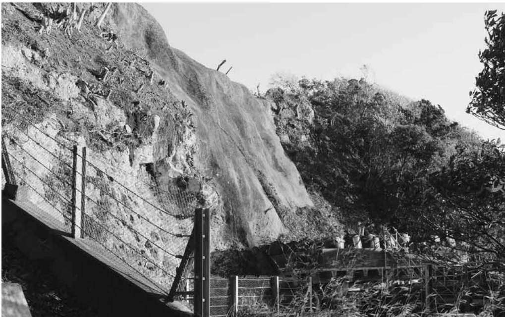
(2) 西斜面南部 (北西から)
