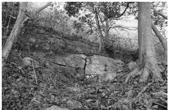
(8) 西谷津北部斜面の石垣 (南西下から)
