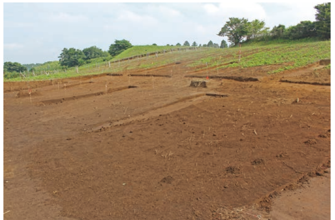
(4)表土除去後風景
