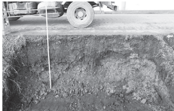
断面② (南東から)
