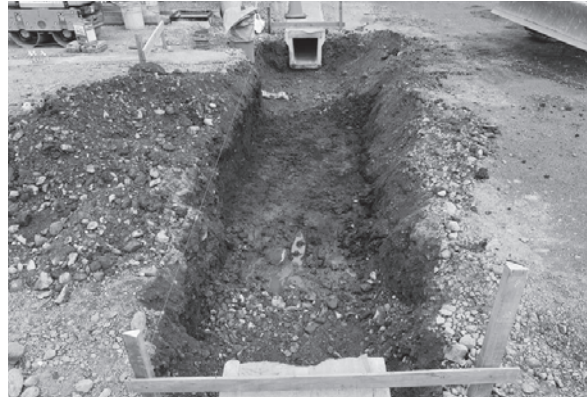
範囲①南側掘削完了状況(南から)
