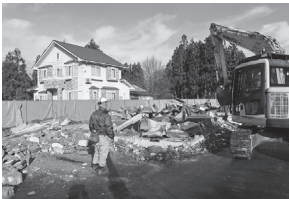
44 置賜学園東遺跡 工事立会(南東から)
