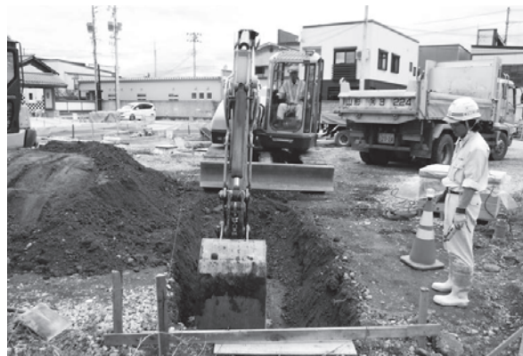
範囲②掘削作業状況(南東から)
