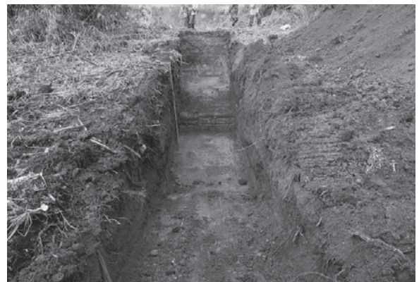
T 13 全景 (南から)
