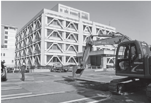
43 山形城三の丸跡隣接地(南東から)
