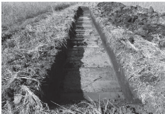
T 22 全景 (南から)
