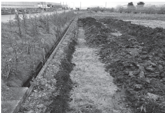
断面①付近確認状況 (南から)
