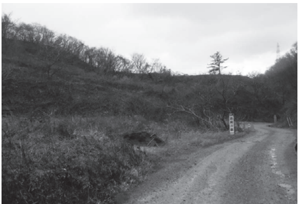
41 一般国道7号朝日温海道路(西から)
