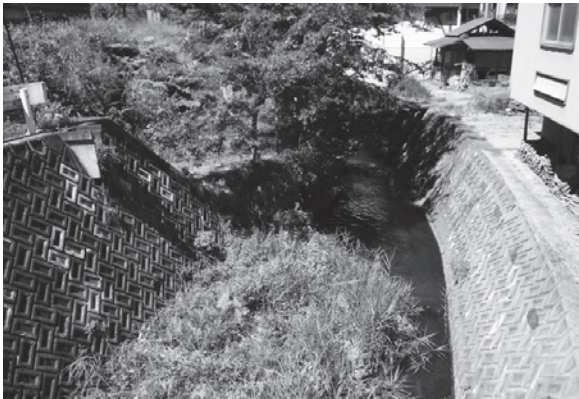
27 送橋川(下芦沢)河川整備単独事業(東から)
