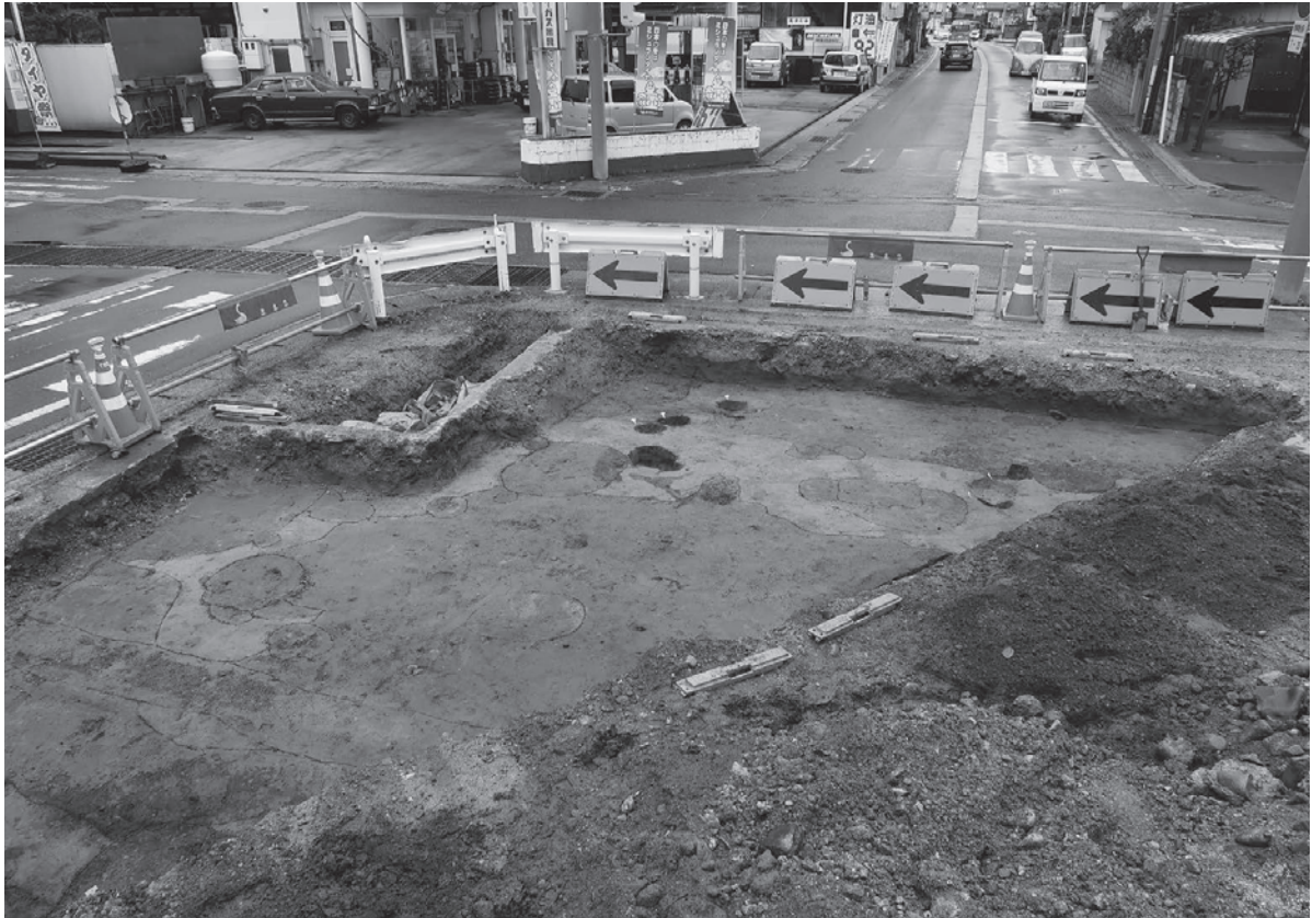
調査区全景遺構完掘状況(南東から)
