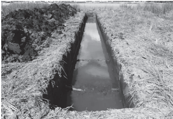
T 20 全景 (南から)
